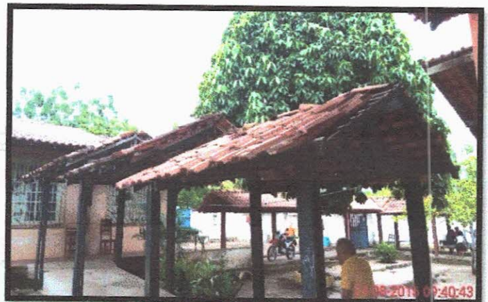
4. ÁREAS DE RETELHAMENTO DE 15M 2
