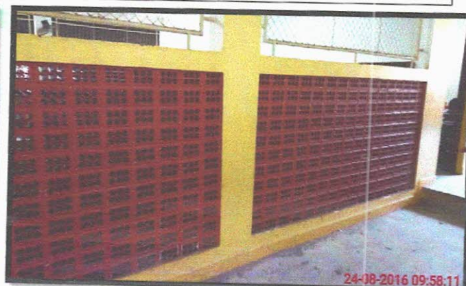
11. VEDAÇÃO DE ELEMETOS COM PVC, ÁREA TOTAL A SER VEDADA 48,29 M 2
