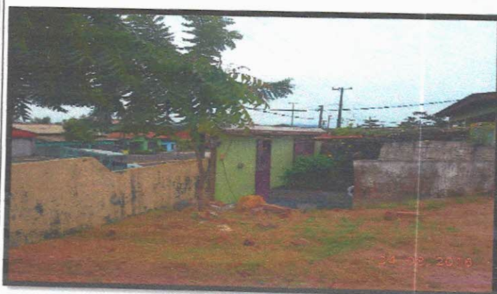
10. CONSTRUÇÃO DE 3,43 X 2,20M DE MURO, INCLUÍDO 2 PILARES
