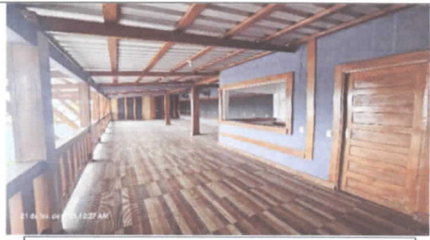
Fotos 9 – Área aberta – piso superior
