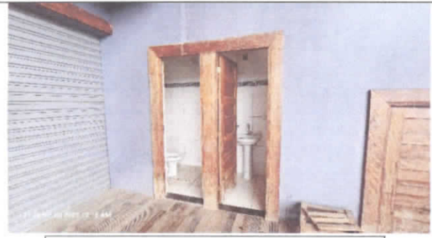
Fotos 8 – Banheiros - térreo
