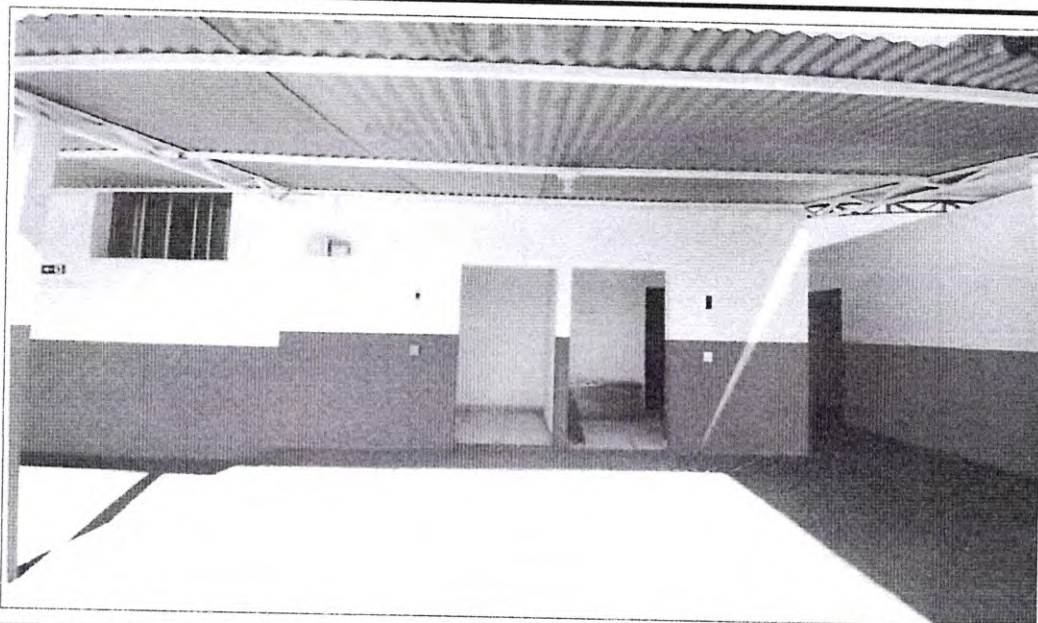
Foto 18: Entrada dos banheiros coletivos feminino e masculino.
