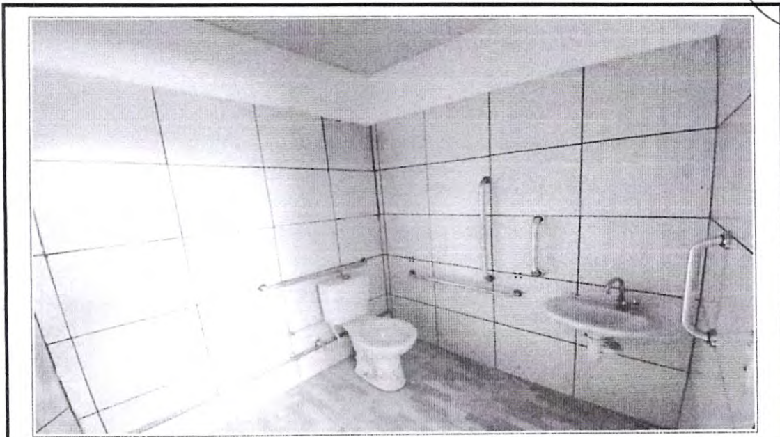
Foto 23: Banheiro PcD atendendo às normas de acessibilidade.
