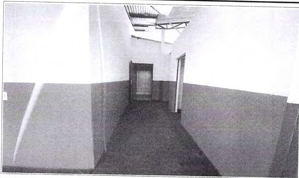
Foto 22: Rampa de acesso ao banheiro PcD atendendo às normas de acessibilidade.
