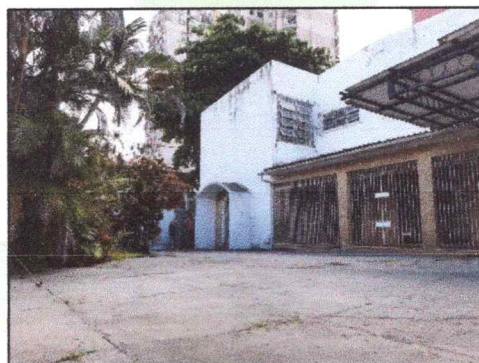
Fotografia 2 – Elevação lateral da residência
