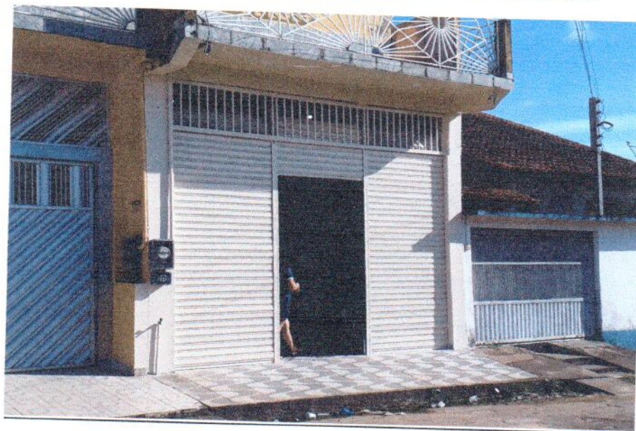
Foto 01- Vista da frente da Edificação.
