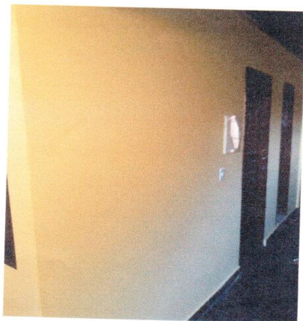
Fotos 02- vista interna da circulação.
