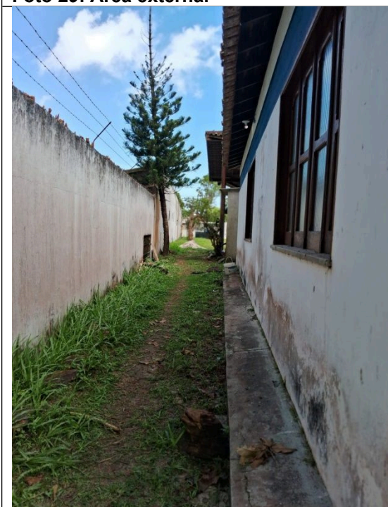
Foto 31: Corredor de circulação da área externa.
