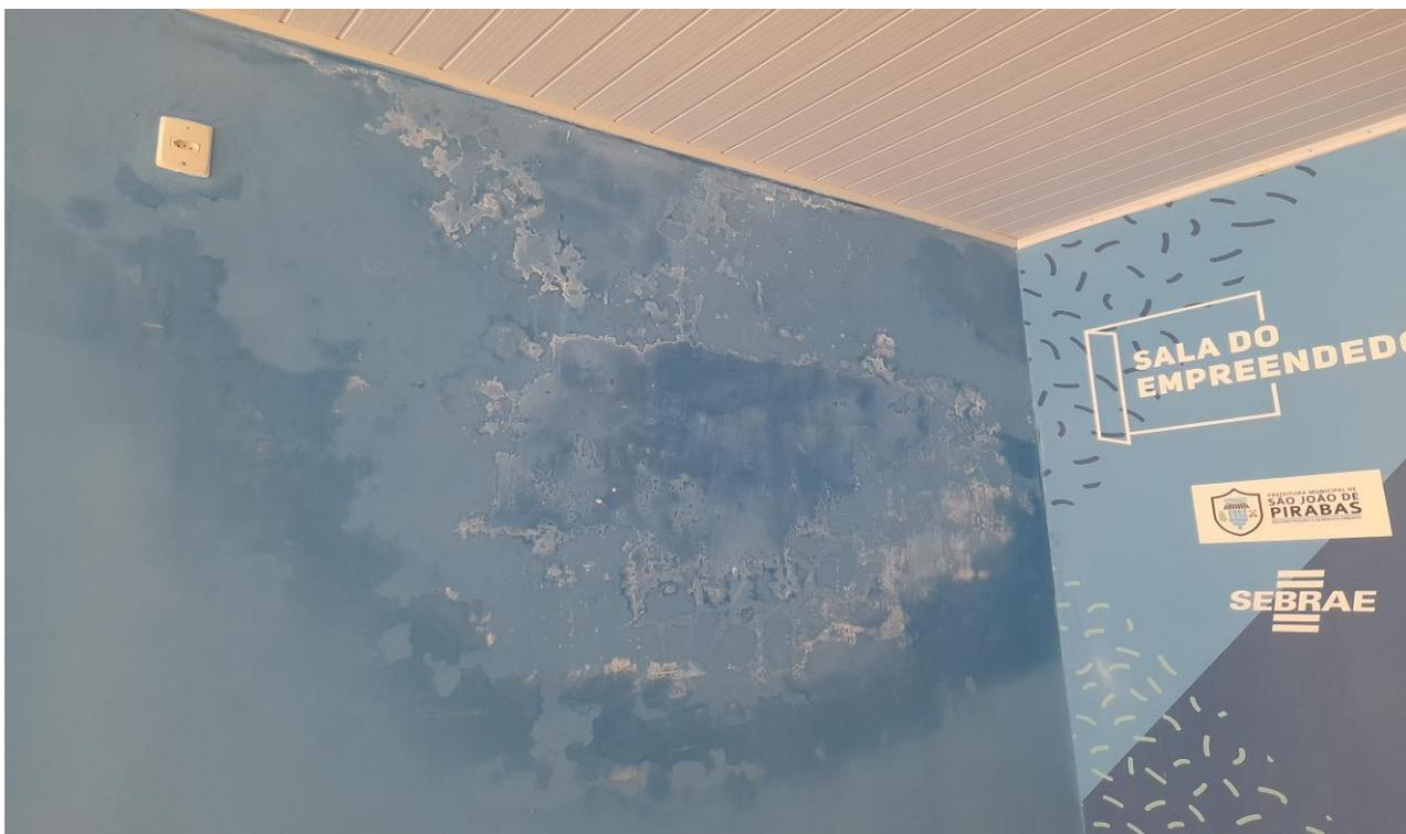
FOTO 10: PONTO DE INFILTRAÇÃO A SER TRATADA – 1º PAVIMENTO.
