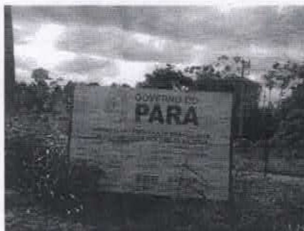
Foto 1.0 - Placa de Obra posicionada na Rua Anchieta
