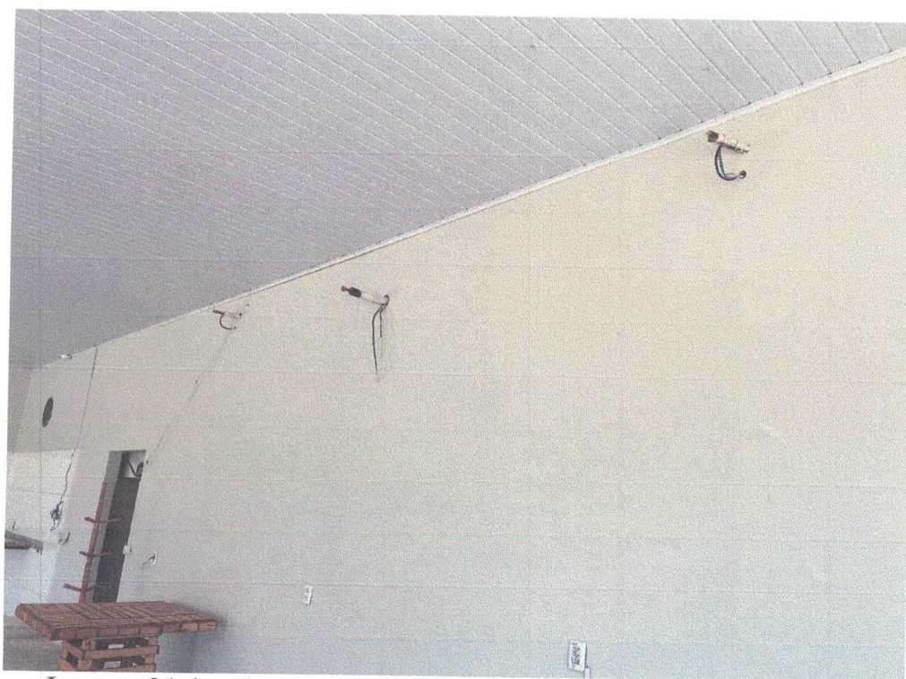
Imagem 24: instalações prévias (provavelmente para ar-condicionado).
