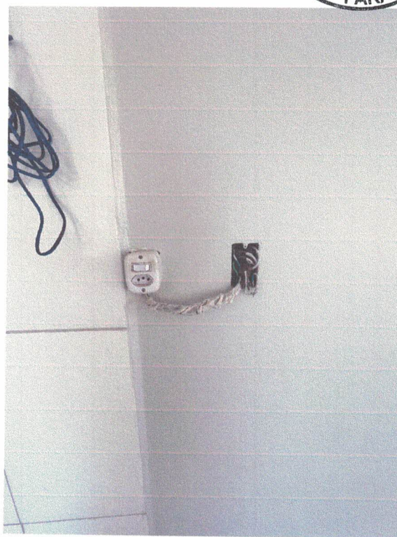
Imagens 33 e 34: Salão principal – tomadas instaladas inadequadamente (fiação exposta).
