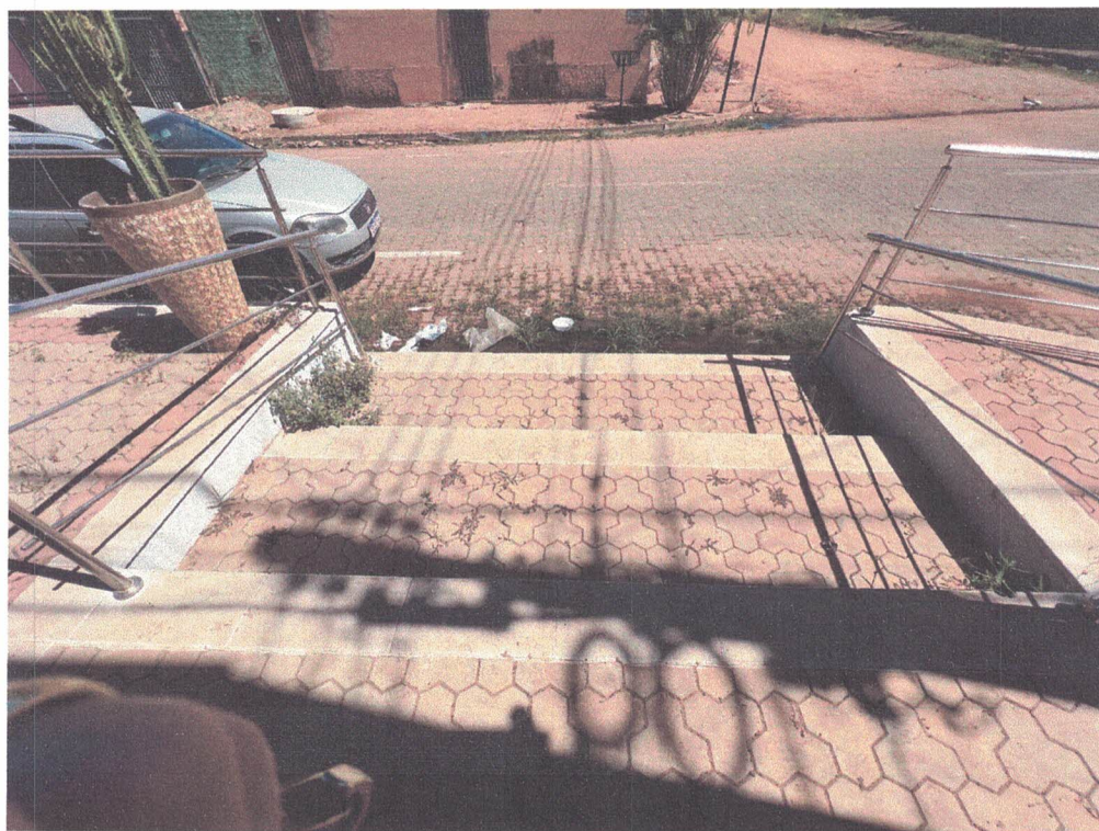
Imagem 03: Escada na calçada para acesso à edificação, pela Rua Gorotire.
