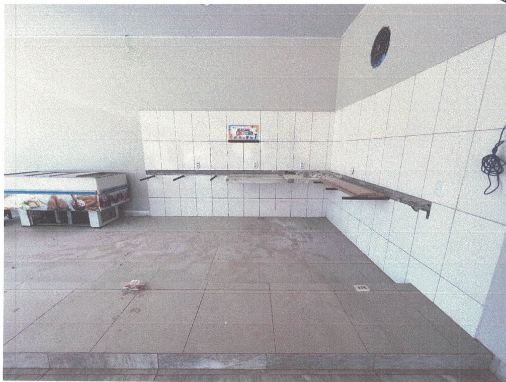
Imagem 29: Chumbadores e pedras de uma bancada; revestimento e exaustor na parede.
