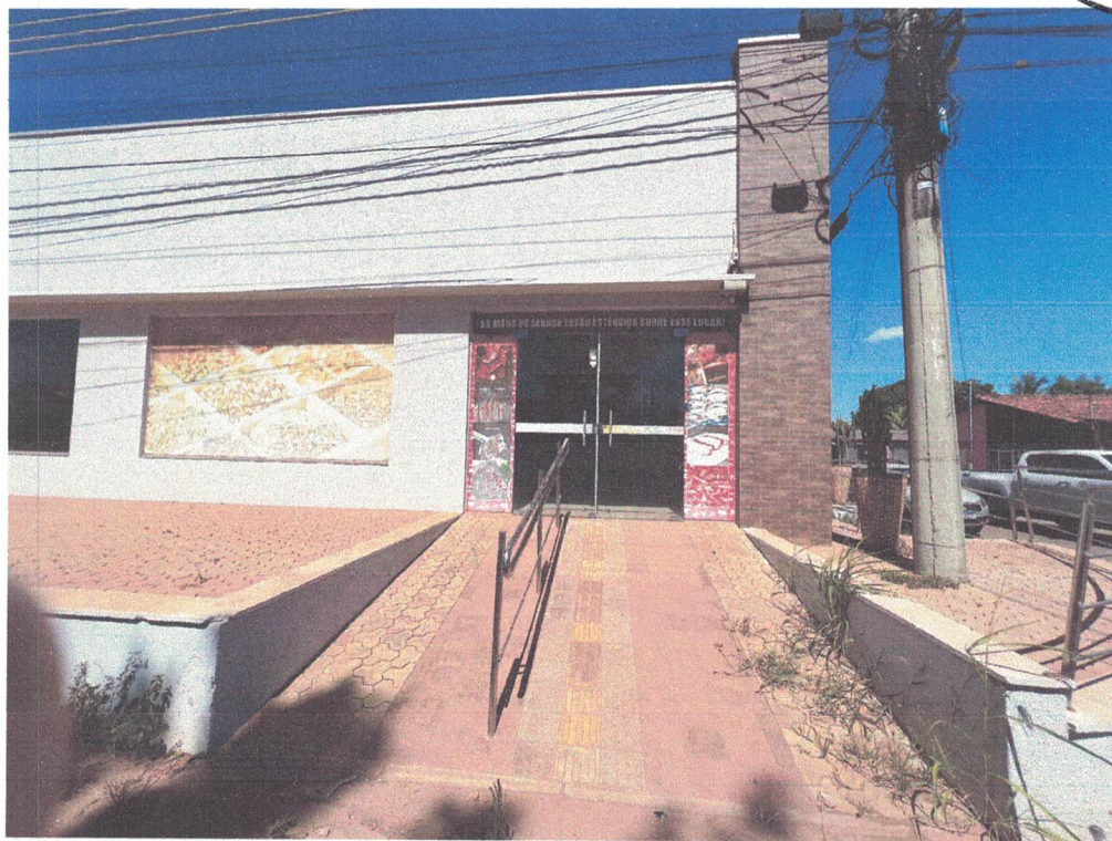
Imagem 06: Rampa na calçada para acesso à edificação pela Rua Cruz e Souza.
