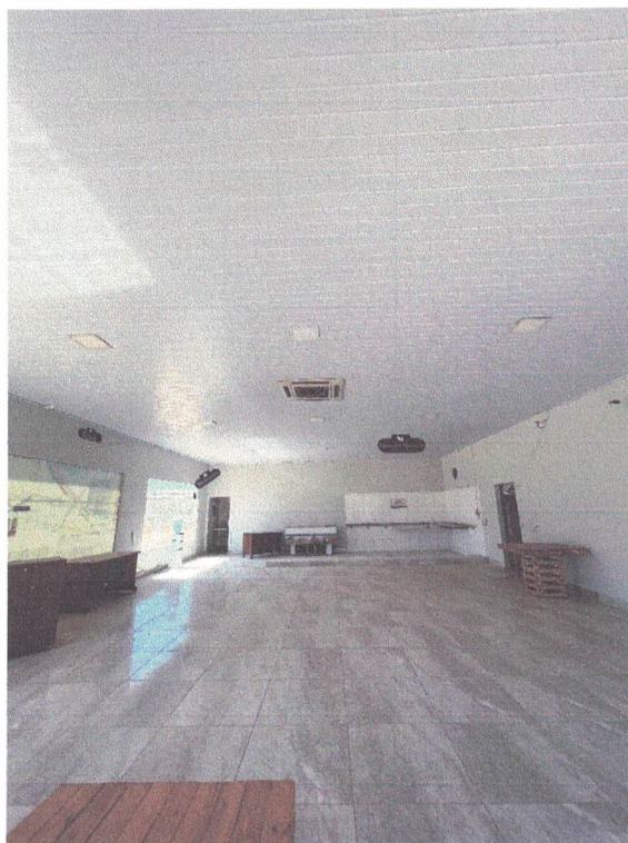
Imagem 08: visão geral do salão principal da edificação.
