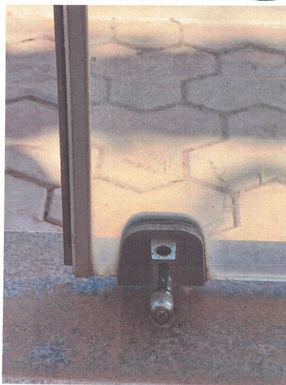
Imagens 15 e 16: fechadura, puxador e tranca de pressão (no piso) da porta de acesso à edificação pela Rua Gorotire.
