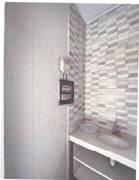
Imagens 37 e 38: Vistas internas do lavabo da edificação (quadro de energia sem tampa de proteção).
