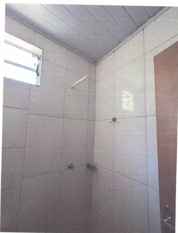
Imagem 51: banheiro 2 – encanação para chuveiro.
