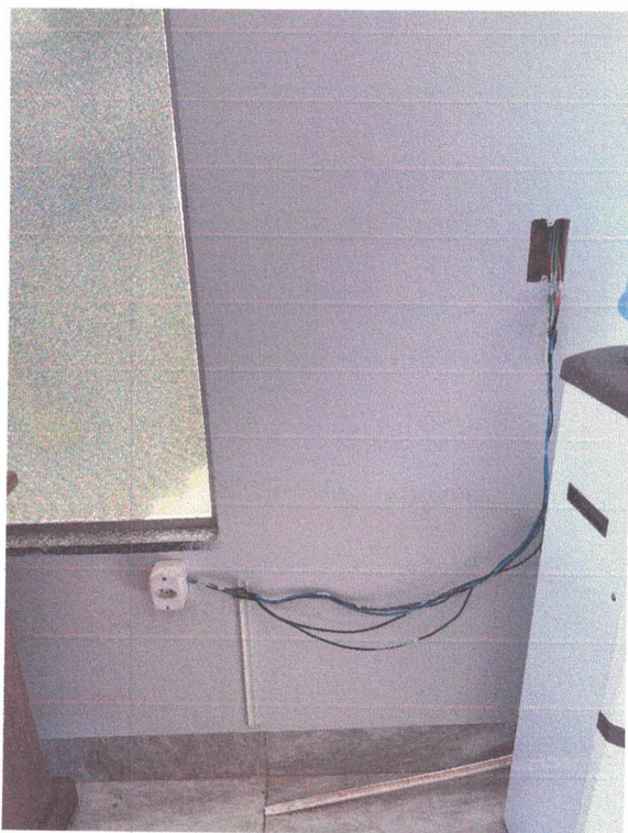
Imagens 33 e 34: Salão principal – tomadas instaladas inadequadamente (fiação exposta).
