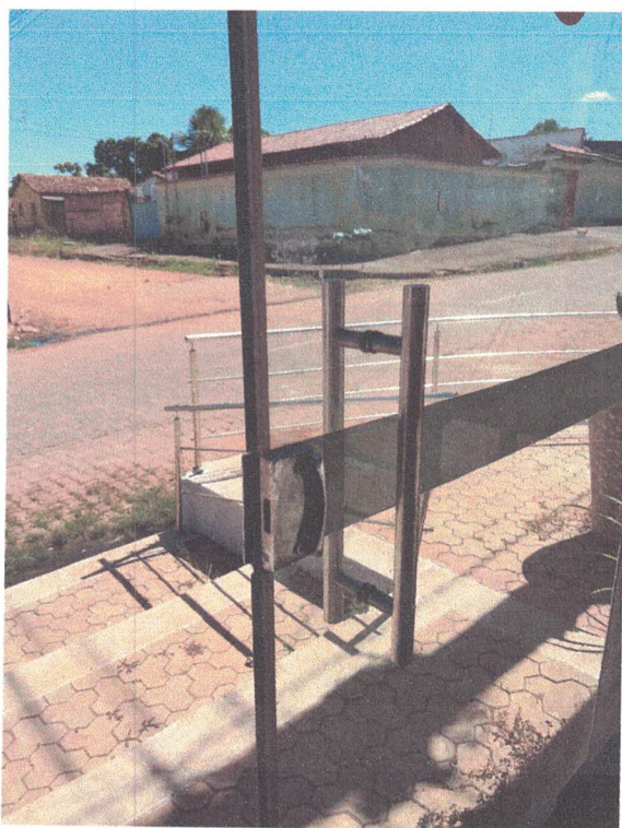
Imagens 15 e 16: fechadura, puxador e tranca de pressão (no piso) da porta de acesso à edificação pela Rua Gorotire.
