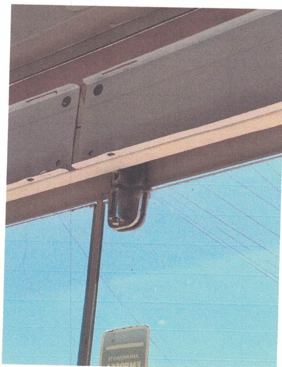
Imagens 19 e 20: Trancas de pressão (de piso e superior) da porta de acesso à edificação pela Rua Cruz e Souza.
