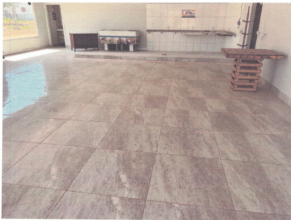
Imagem 27: Piso do salão principal da edificação.
