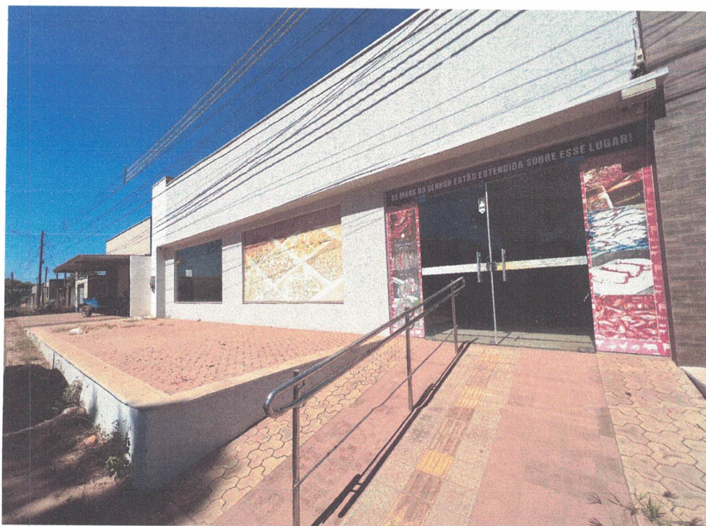
Imagem 07: Fachada e rampa na calçada para acesso à edificação pela Rua Cruz e Souza.
