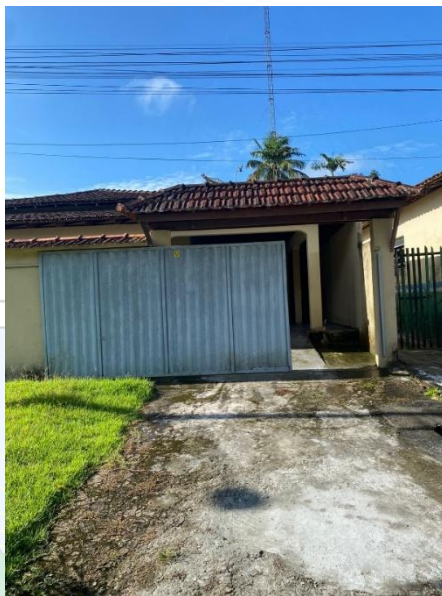
Foto 01: Vista frontal/fachada, próprio, 2025.
