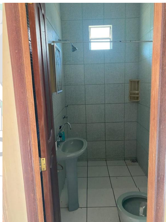
Foto 06: Banheiro social, próprio,2025.
