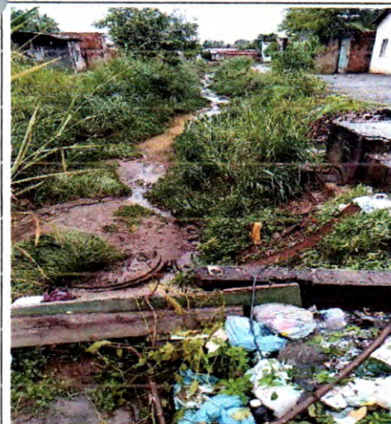
Figura 88 – Rua São Lázaro - Altamira
