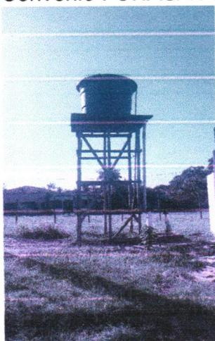
Foto Mostra : Situação da fornecimento de Abastecimento de Agua do Conjunto Pedrolândia, até a conclusão dos serviços de Construção do Sistema de Abastecimento com Elevado de 100m<sup>3</sup>. O Conjunto Pedrolândia era abastecido por um sistema com uma Caixa de Fibra de Vidro de 5 mil litros.
