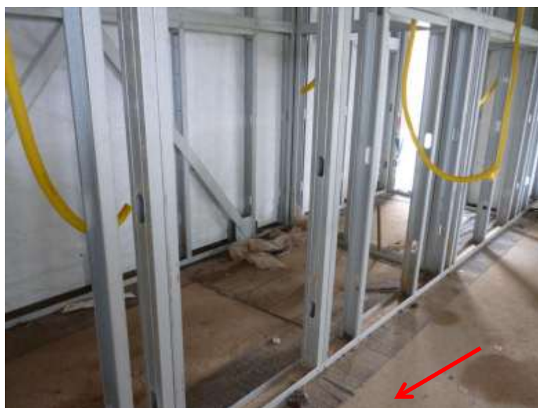
Figura 3 – Fixação de estrutura a fundação
