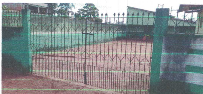
Portão de serviço 01.
