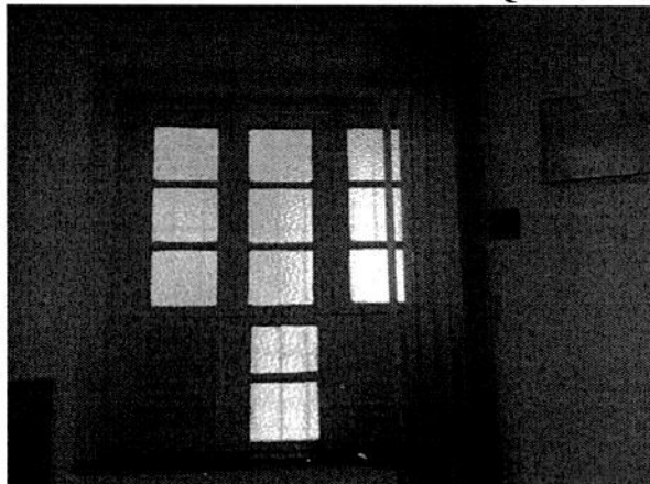
FIGURA 23 – DETALHE DAS ESQUADRIAS
