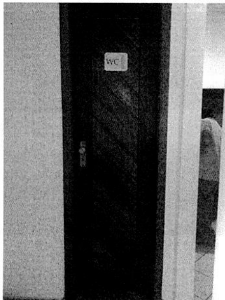
FIGURA 20 – PORTA DO BANHEIRO
