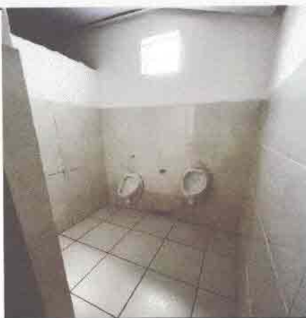
BANHEIRO FUNCIONÁRIOS MASCULINO
