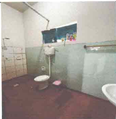
BANHEIRO QUARTO HÓSPEDES
