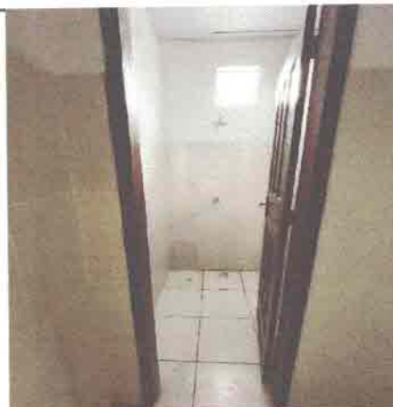
BANHEIRO FUNCIONÁRIOS MASCULINO
