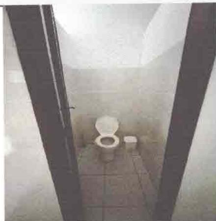
BANHEIRO FUNCIONÁRIOS MASCULINO
