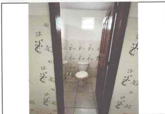
BANHEIRO FUNCIONÁRIOS FEMININO
