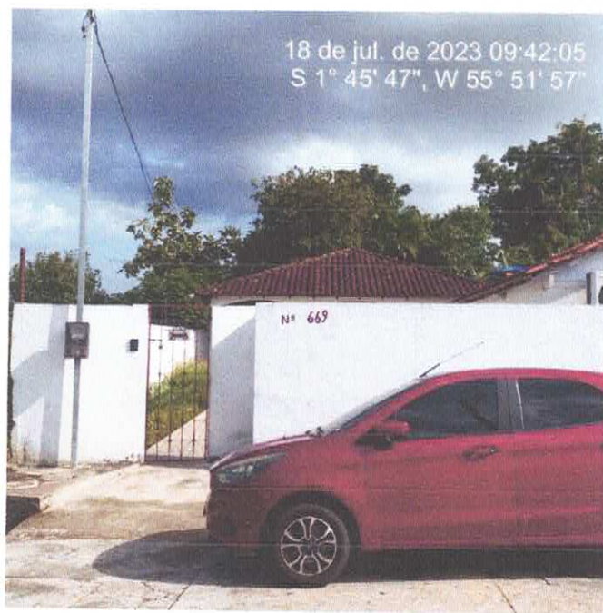
Figura 1 – Fachada da Edificação
