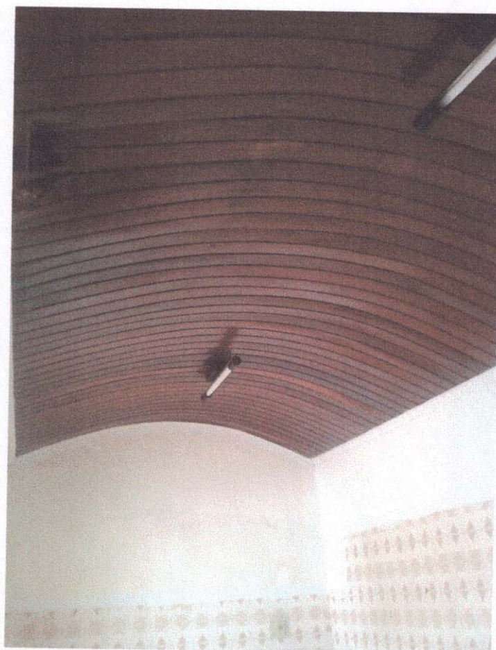
Foto 06 – Forro de Madeira
