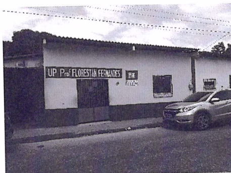
FOTO 12- FACHADA DO IMÓVEL
