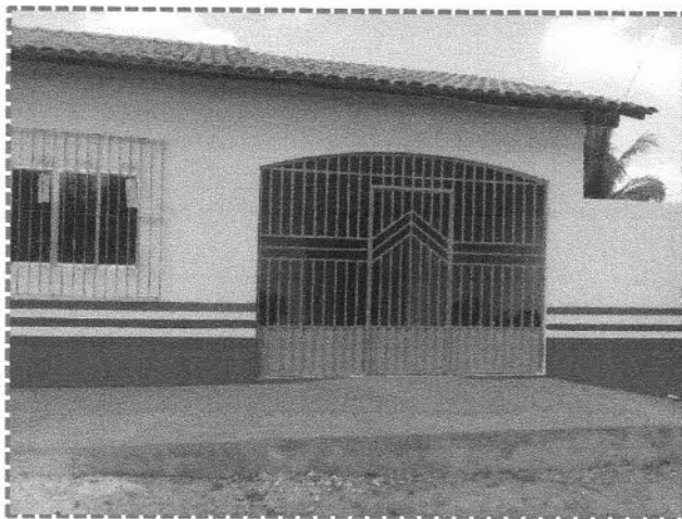
Foto 01: Fachada principal do imóvel
