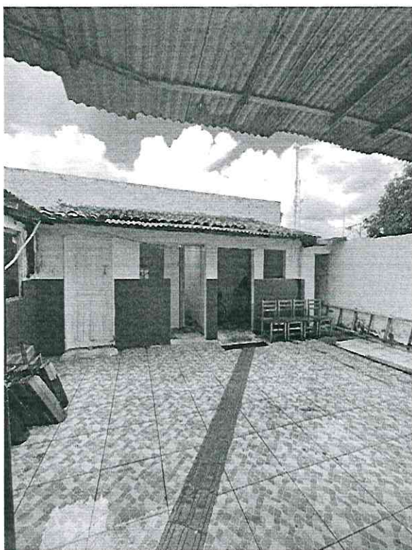
Figura 10 - anexo de banheiros
