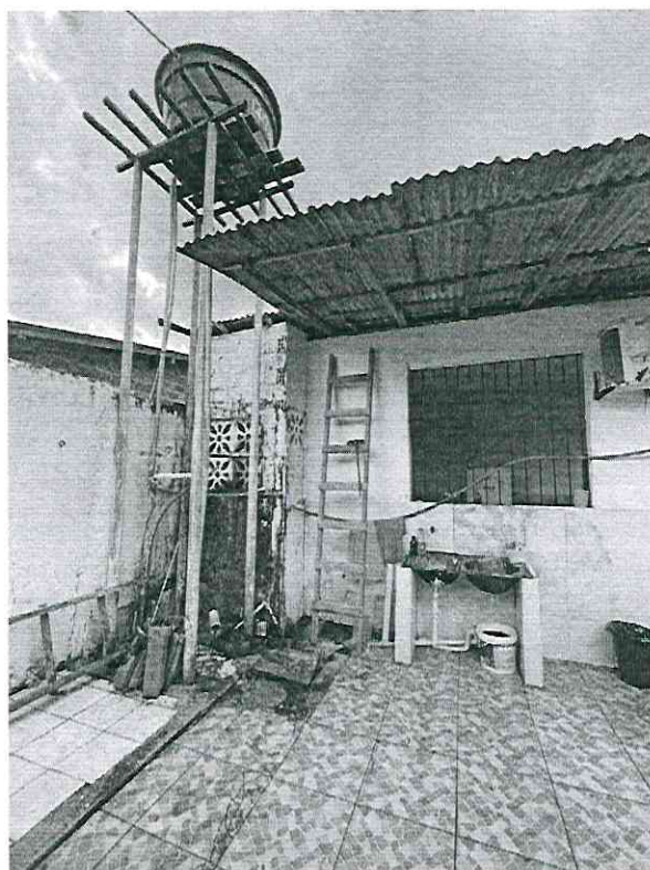
Figura 9 - área de serviço e Estrutura da caixa d'água
