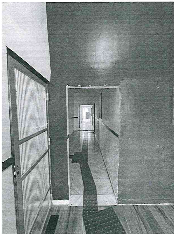
Figura 7 – Corredor de acesso as salas
