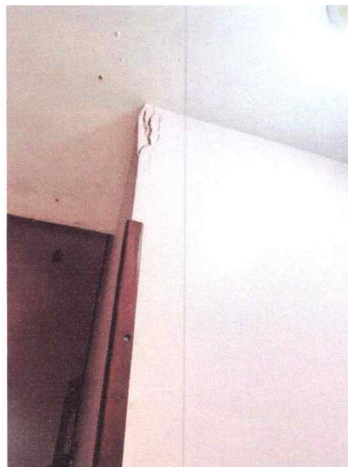
Figura 6: Rachadura
