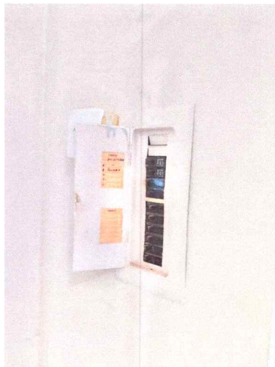
Figura 14: Quadro de medição
