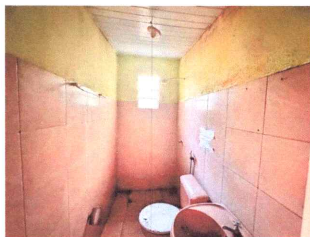
Figura 28: Banheiro de Serviço.
