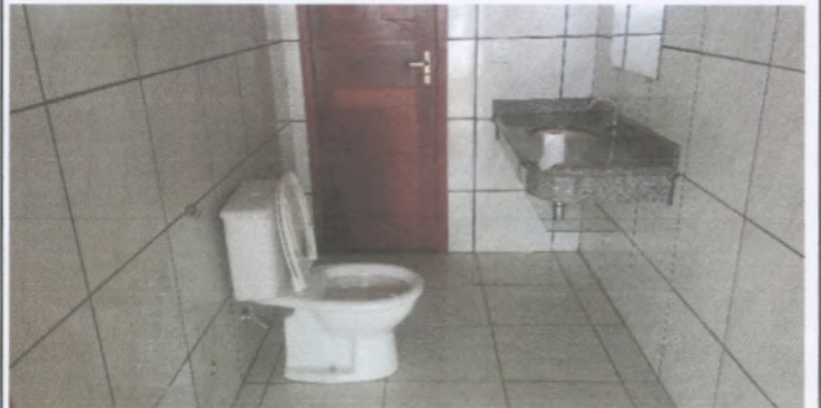
Foto 04 - Banheiro Com entrada externa/interna
