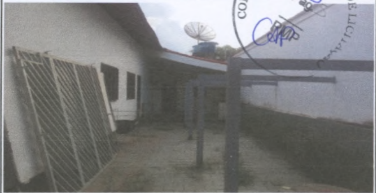
Foto 02 - Área de Serviço
