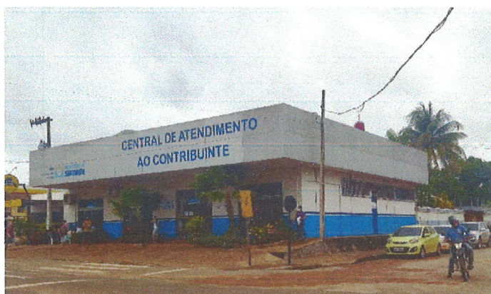
IMAGEM 01: Fachada principal do imóvel vistoriado
