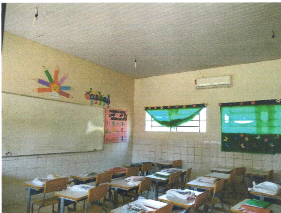
Foto 11 – Sala de aula
