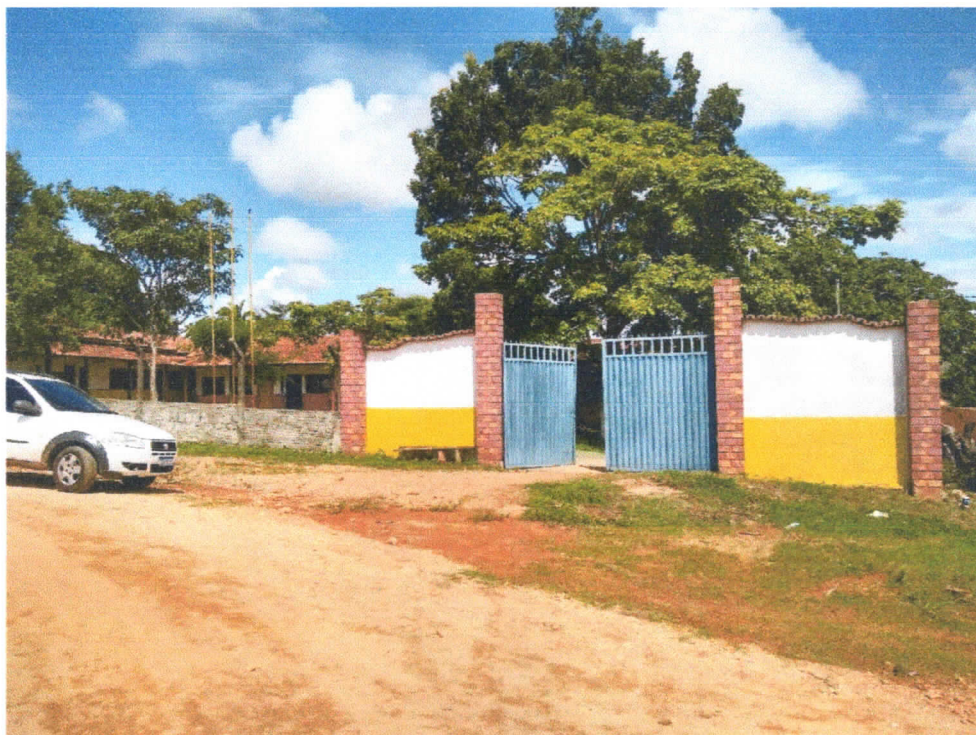
Foto 1 – Fechada/Portão de acesso.
