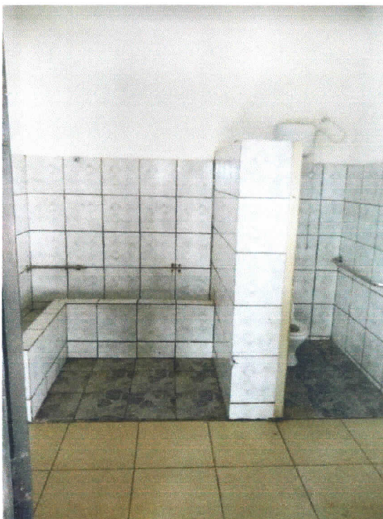
Foto 15 – Banheiro Adaptado (mictório de alvenaria desativado)
