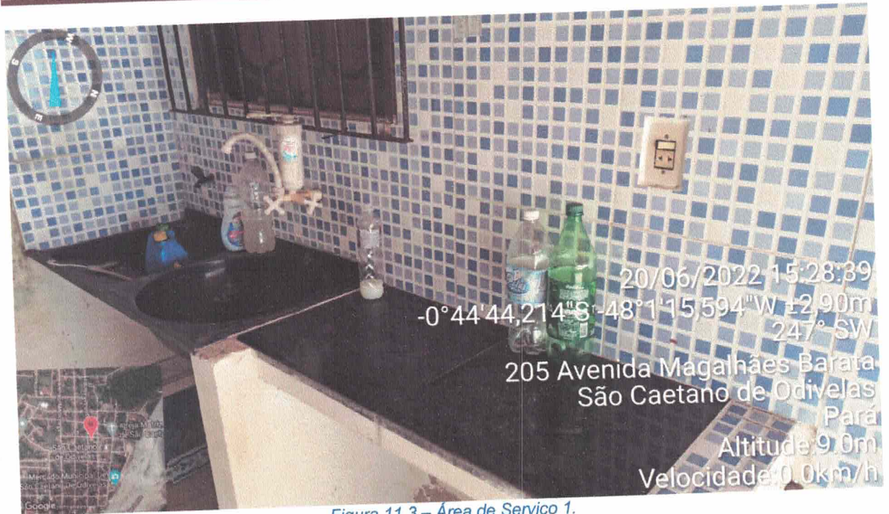
Figura 11.3 – Área de Serviço 1.
