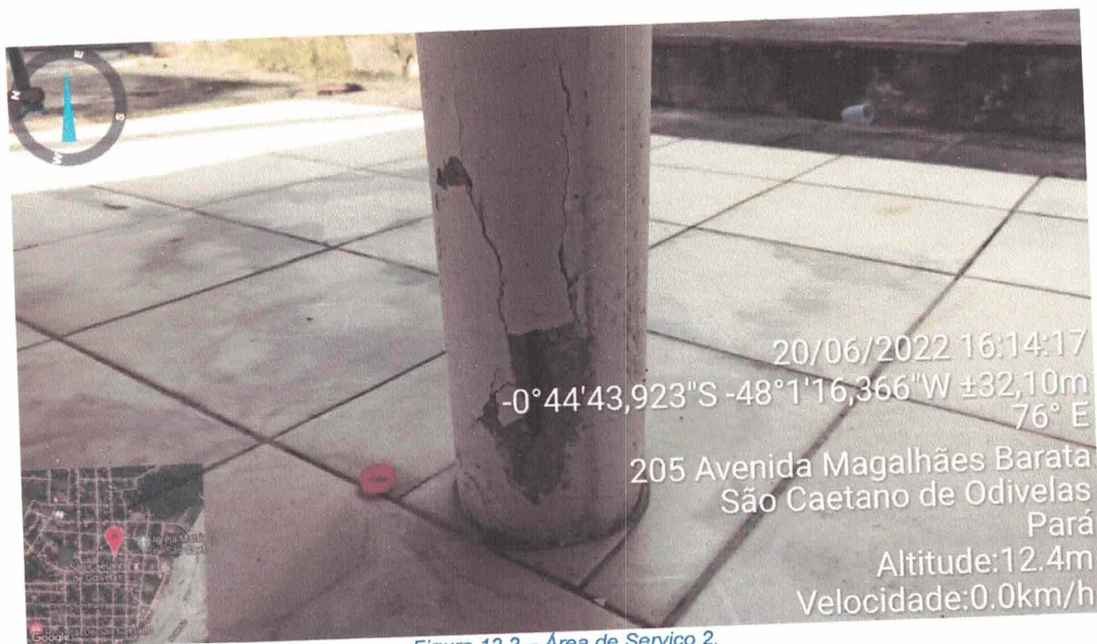
Figura 12.2 – Área de Serviço 2.
