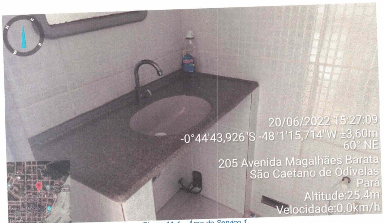
Figura 11.4 – Área de Serviço 1.
