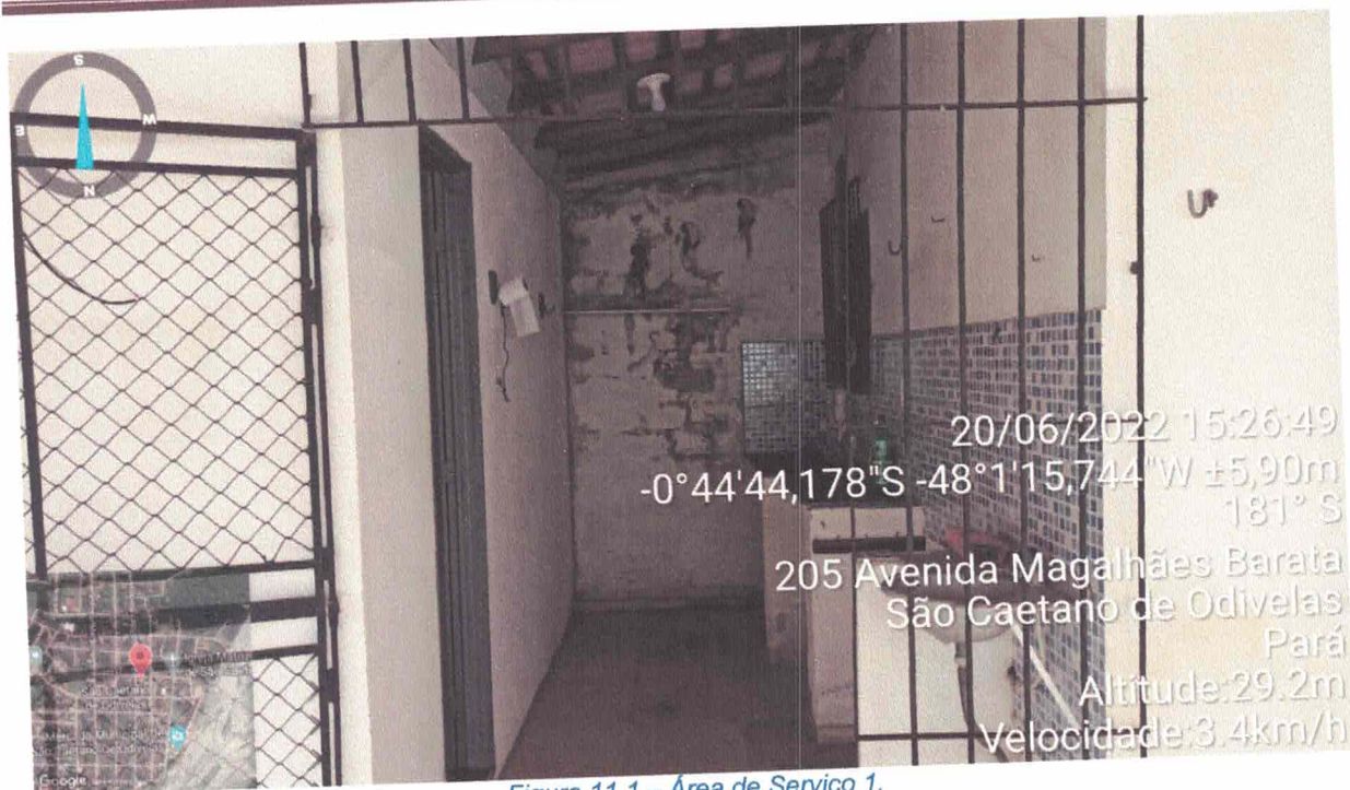
Figura 11.1 – Área de Serviço 1.
