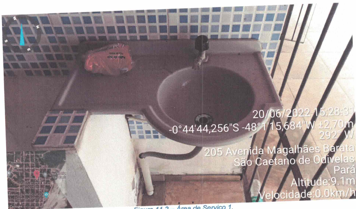
Figura 11.2 – Área de Serviço 1.
