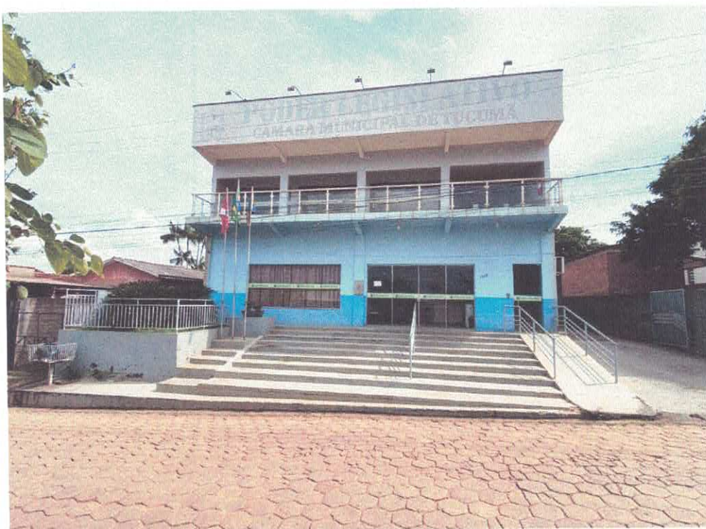
Figura 1: Fachada Principal da Edificação
