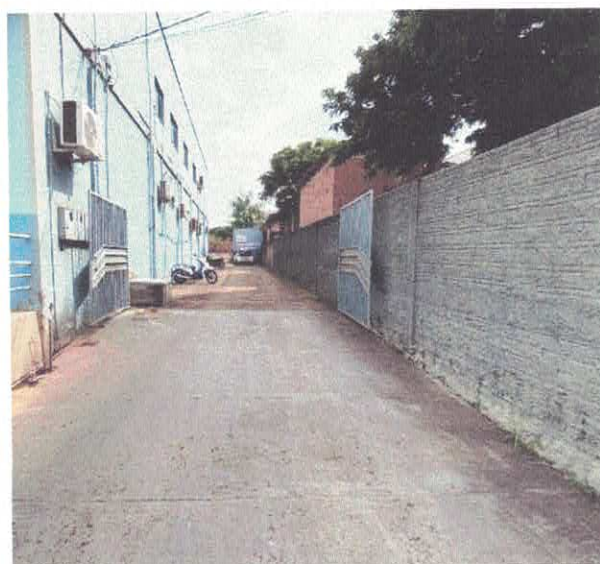
Figura 8: rampa de acesso estacionamento.
