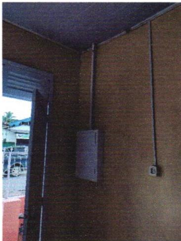
Foto 15 – Caixa de distribuição elétrica.
