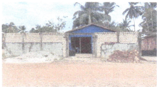
Foto 01: Vista principal do prédio.
