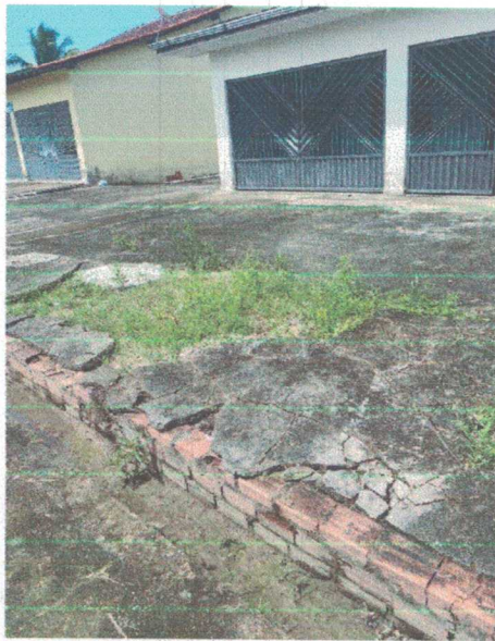
Piso e canaleta de acesso ao prédio.
