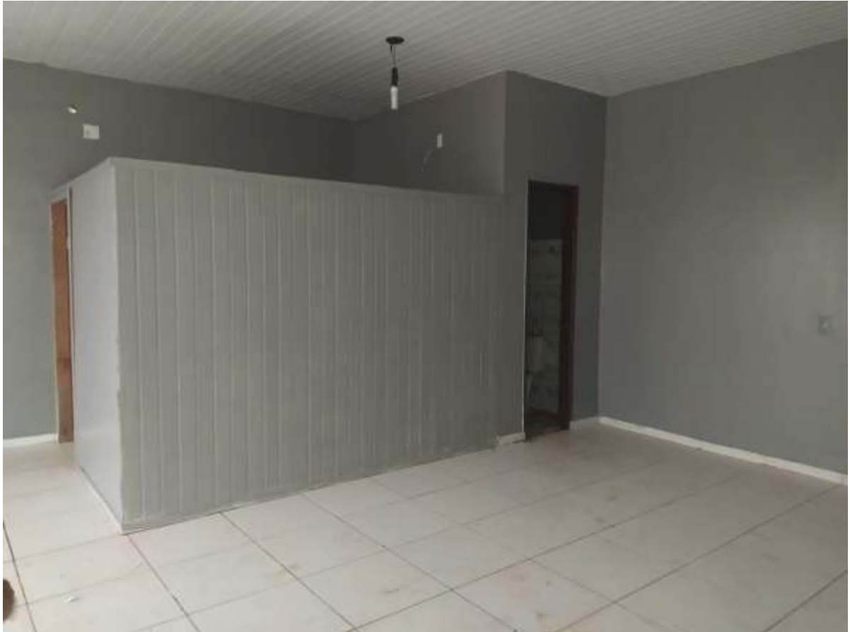
Parede de pvc.
