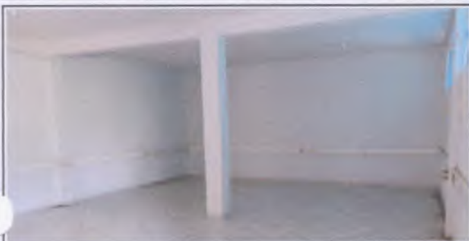
Foto 13: Salão no térreo do prédio
