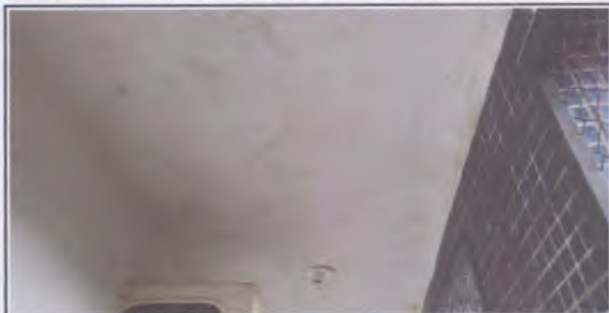
Foto 14: Infiltrações identificadas
