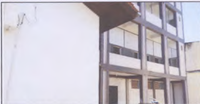
Foto 12: Vista externa do prédio aos fundos
