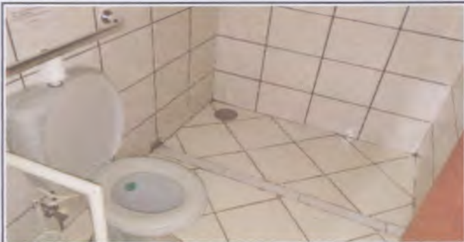
Foto 11: Banheiro adaptado térreo
