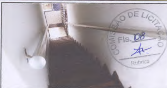
Foto 02: Escada de acesso à pavimentos Sup.
