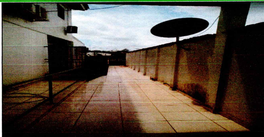
Fotografia 1: Entrada do pavimento inferior.
