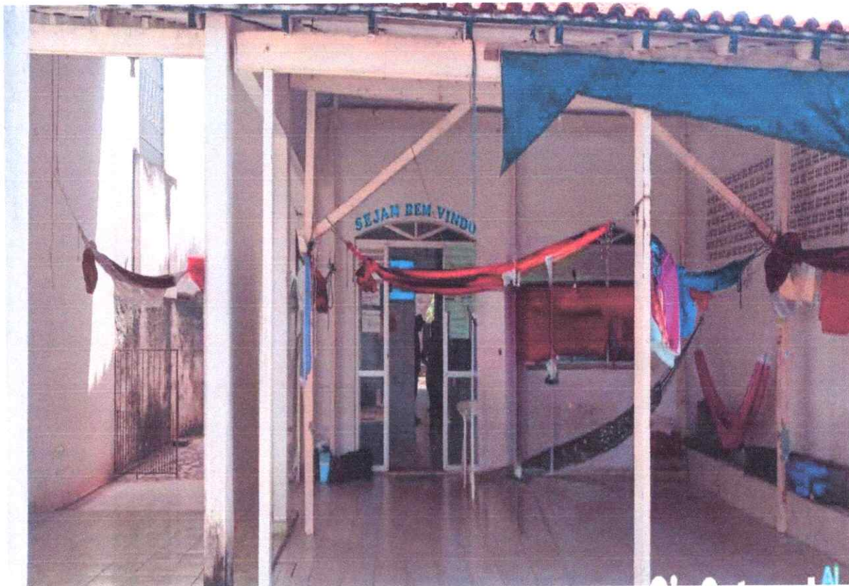
Foto 13: Área externa coberta
