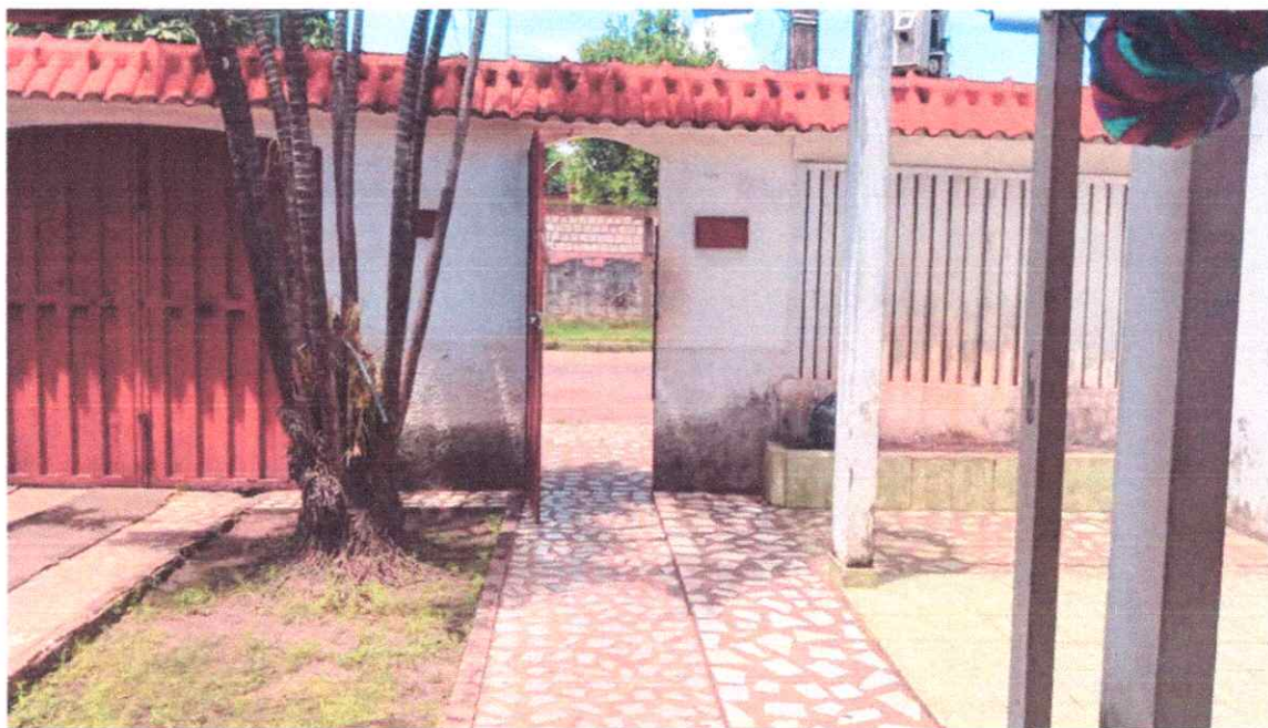
Foto 02: Entrada (por dentro)
