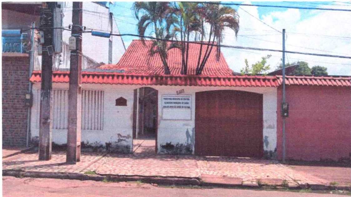
Foto 01: Frente do imóvel
