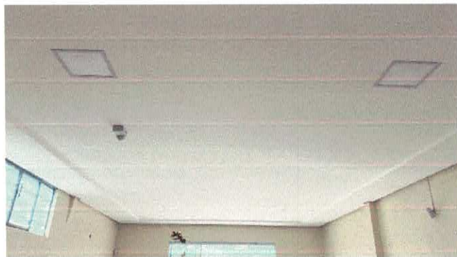
Forro do Prédio
