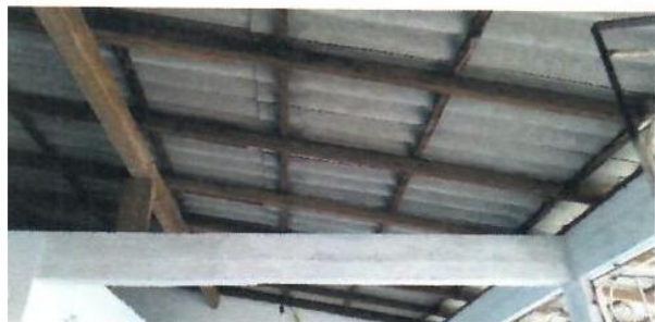
VISTA COBERTURA ANEXO
