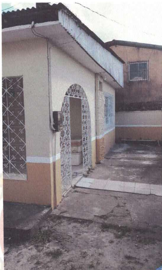
Imagem 03: Fachada (Vista interna)
