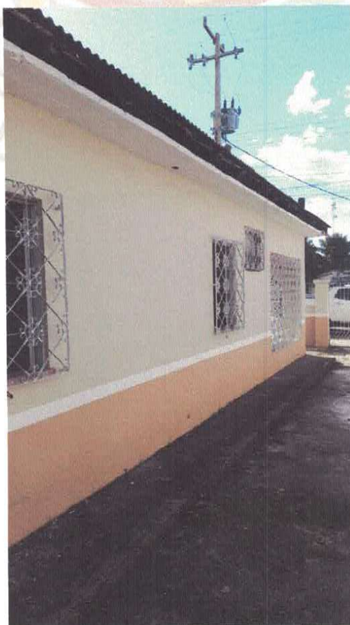
Imagem 04: Fachada (Vista lateral esquerda – fundos para frente)
