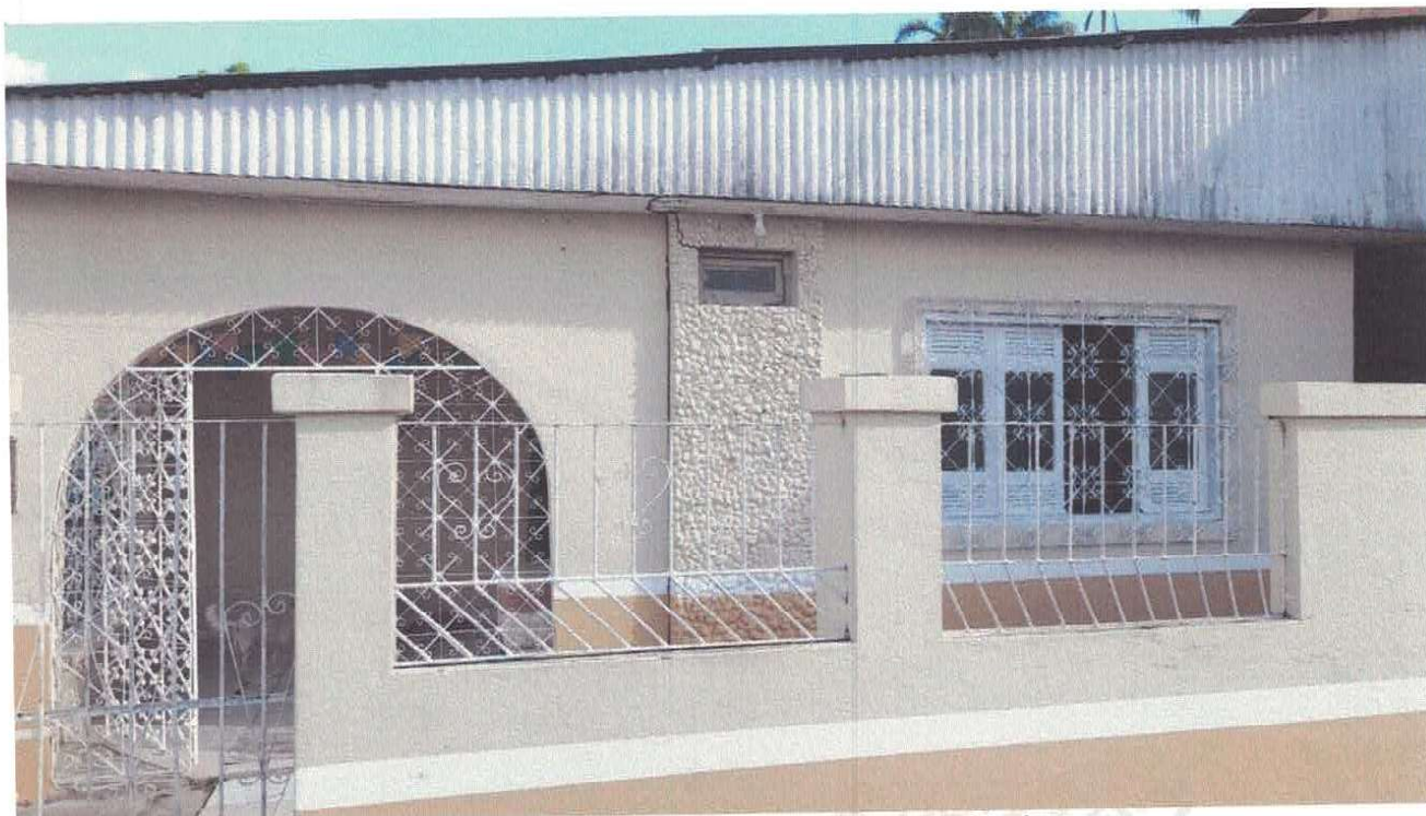
Imagem 02: Fachada (Vista pela Rua)
