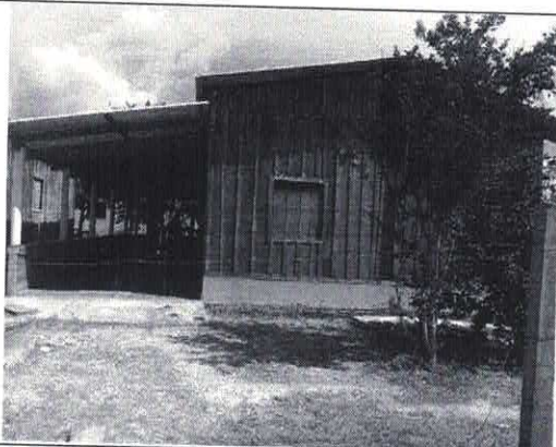
IMAGEM 01: Fachada frontal do imóvel. Edificação em madeira, cobertura em telha de fibrocimento, caracteriza um padrão baixo de acabamento.
