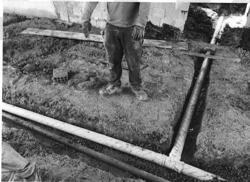
Figura 18 - Instalação dos tubos de drenagem
