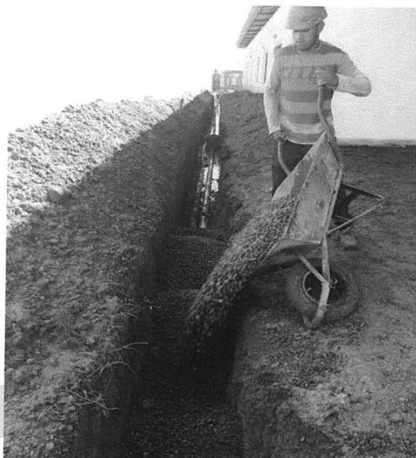
Figura 21 – Serviços de drenagem sendo executado, utilização do seixo
