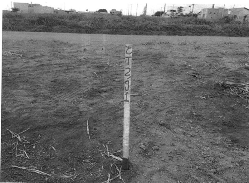
Figura 7 – Demarcação da topografia para área de corte
