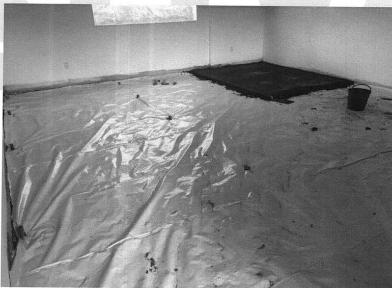
Figura 22- Aplicação de lona para impermeabilização e execução do contrapiso impermeabilizado
