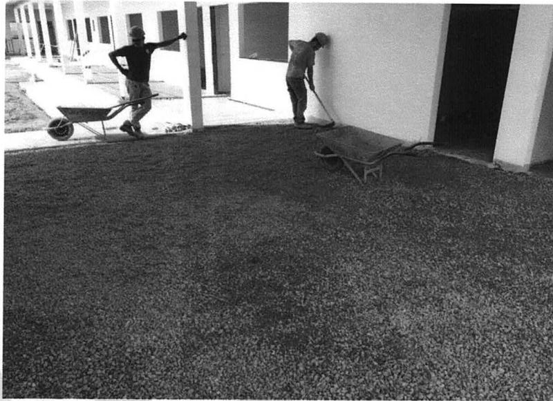
Figura 23 - Utilização do seixo na execução dos serviços de drenagem
