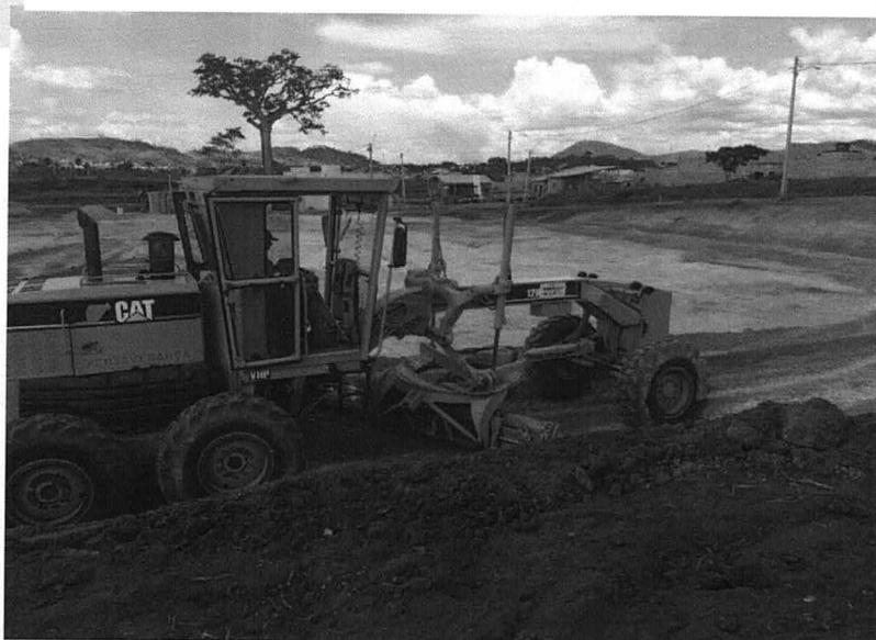
Figura 2 - Uso de Motoniveladora para realização de nivelamento do platô
