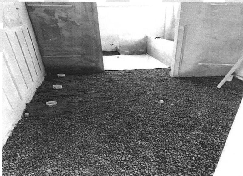
Figura 24 - Utilização do seixo na execução dos serviços de drenagem
