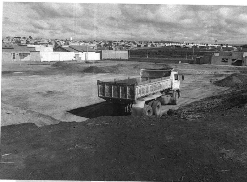
Figura 3 – Uso de caminhão para substituição de solo podre por aterro adequado
