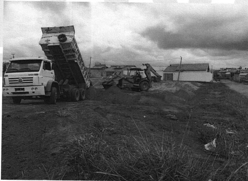
Figura 6 – Aterro adequado sendo descarregado para execução platô
