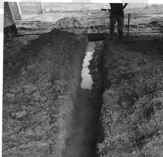
Figura 10 – Escavação de valas para execução de serviços de drenagem
