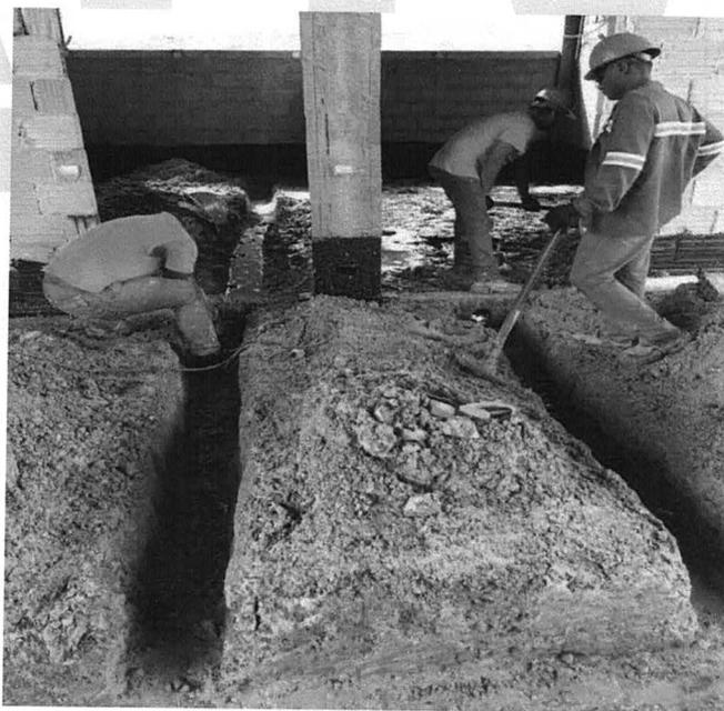
Figura 12 – Escavação para execução de serviços de drenagem
