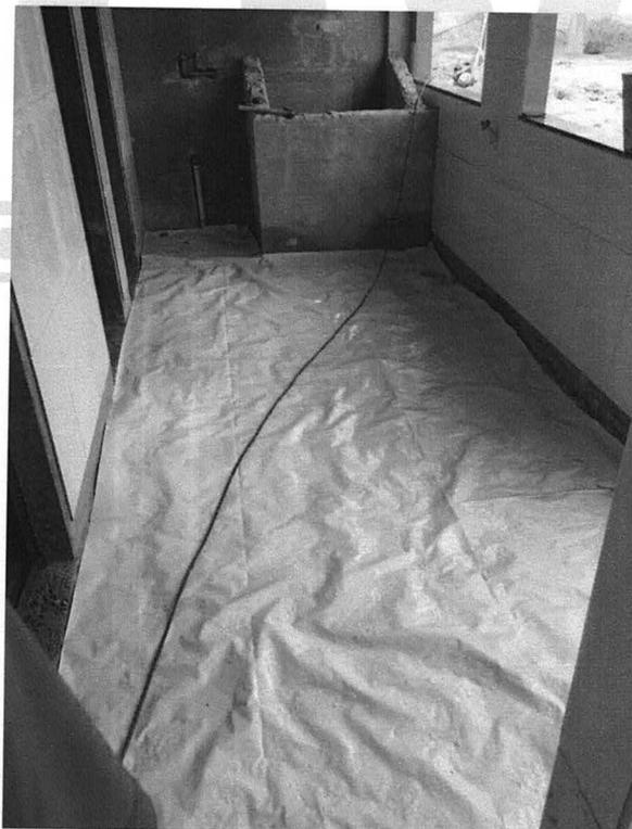
**Figura 26 - Aplicação de lona para impermeabilização e execução do contrapiso impermeabilizado**
