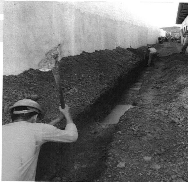
Figura 14 - Escavação de vala para execução de serviços de drenagem
