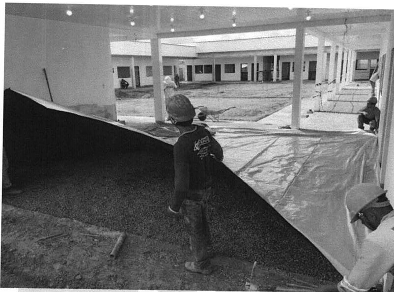
**Figura 25 - Aplicação de lona para impermeabilização e execução do contrapiso impermeabilizado**
