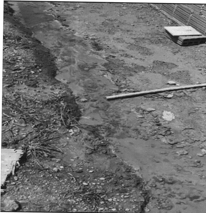
Figura 9 – Minador na superfície do solo
