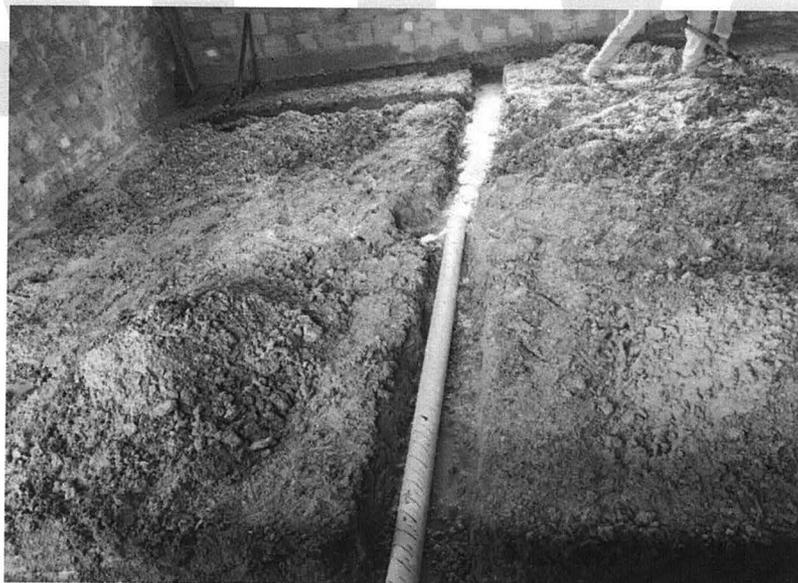
Figura 16 - Instalação dos tubos de drenagem
