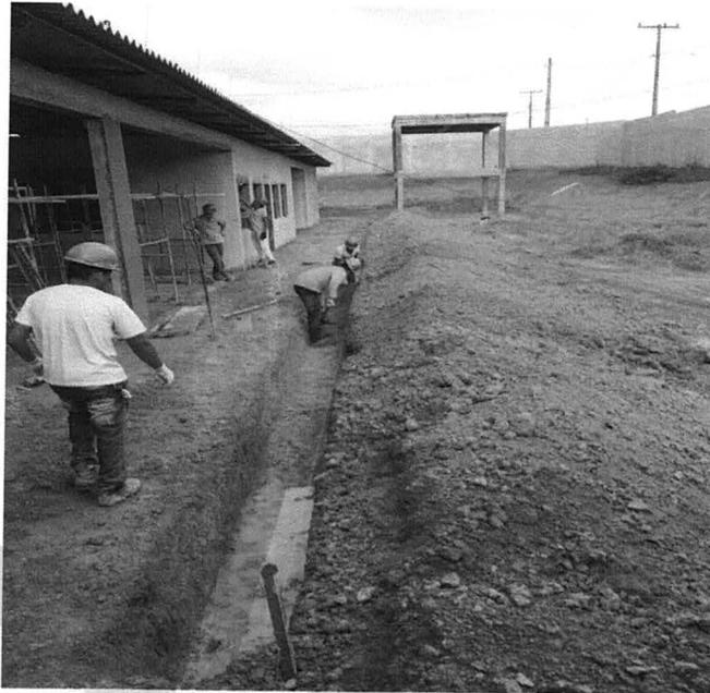
Figura 13 - Escavação de vala para execução de serviços de drenagem
