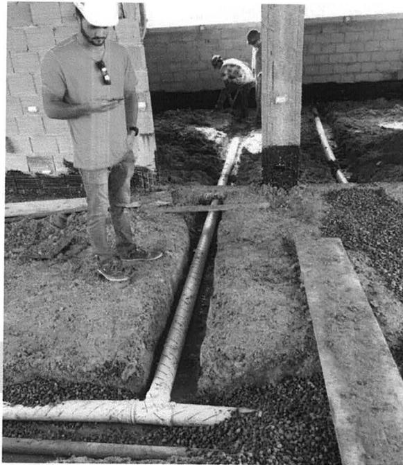
Figura 15 - Instalação dos tubos de drenagem
