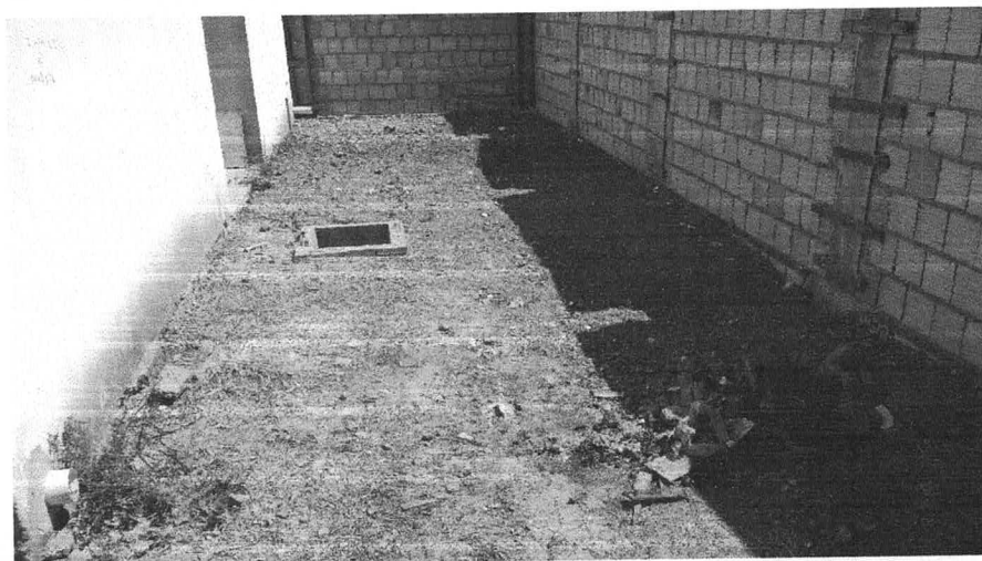
Figura 6 – Muro de Vedação
