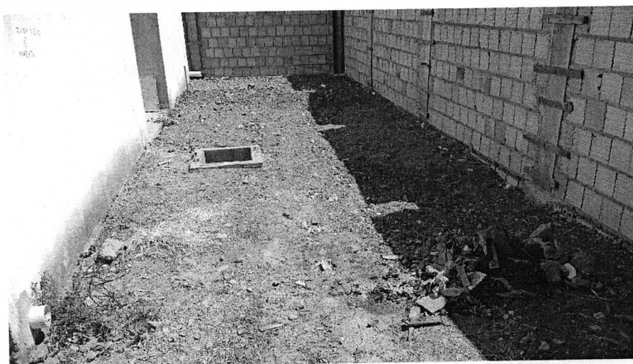
Figura 6 – Muro de Vedação
