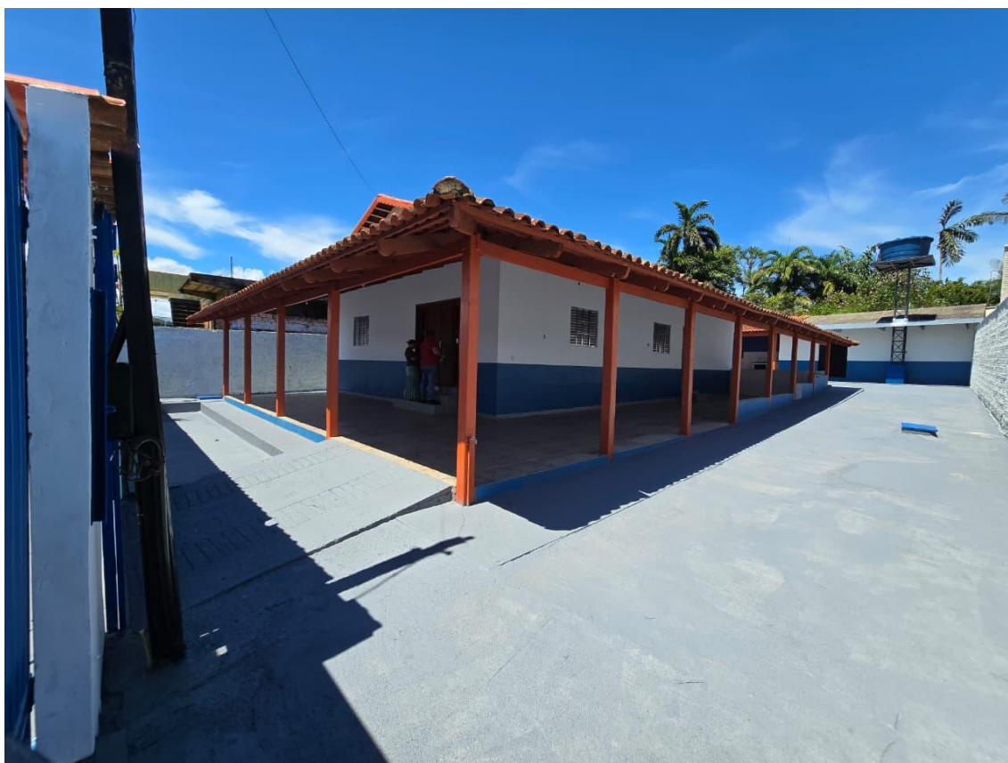
IMAGEM 01 – VISTA EXTERNA DA EDIFICAÇÃO.
