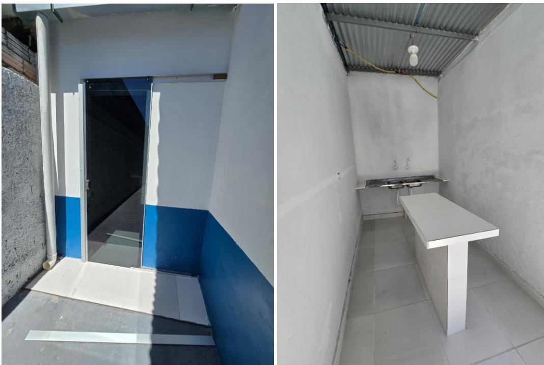
IMAGEM 09 / 09.1 –. AMBIENTE EXTERNO COM ACESSO PELA LATERAL ESQUERDA.
