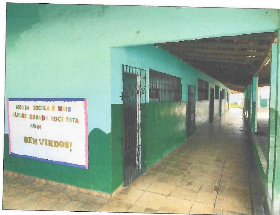
Vista interna pátio de entrada da edificação
