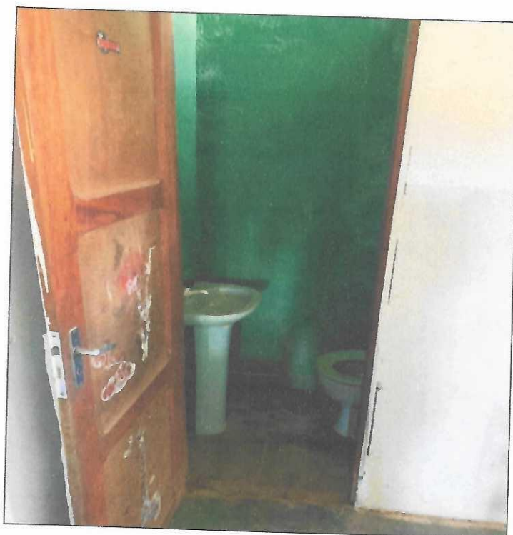
Vista banheiro sala 02
