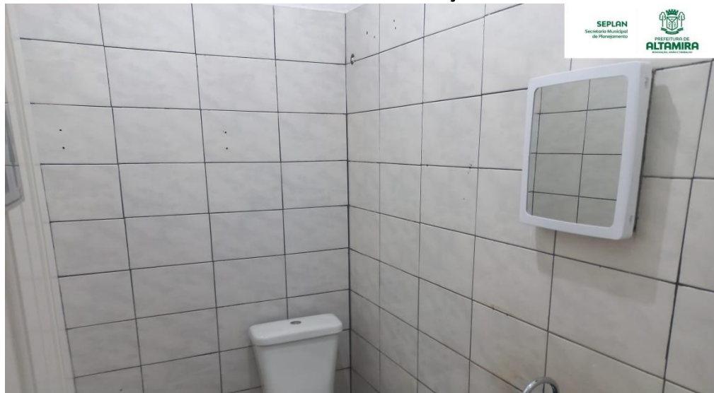
Foto 09 – Banheiro da edificação
