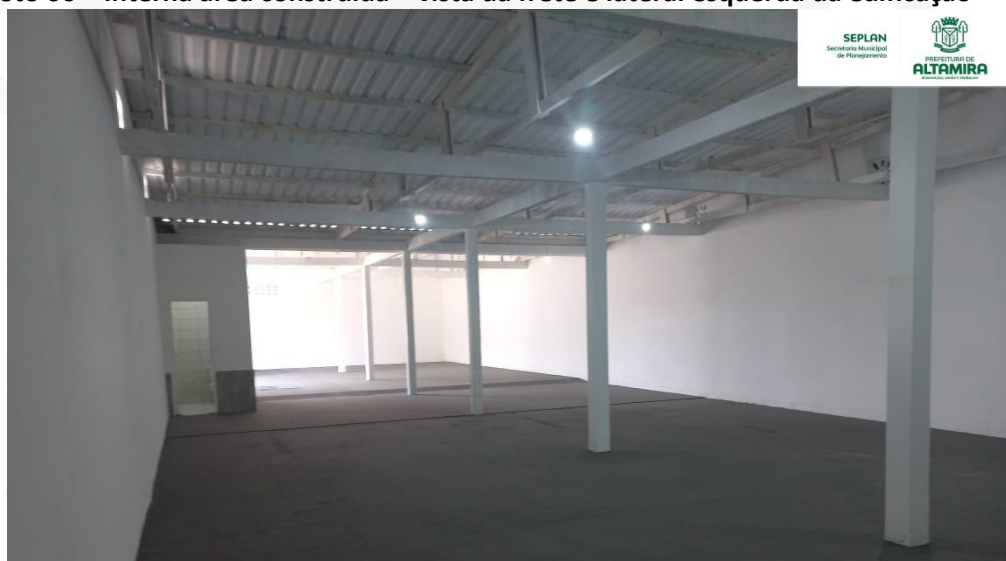
Foto 06 – Interna área construída – vista da frete e lateral esquerda da edificação
