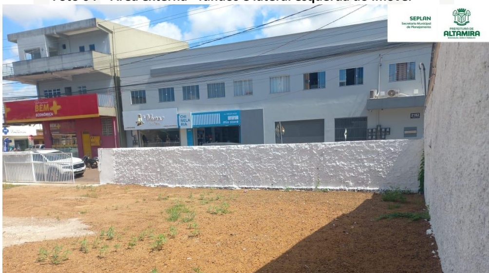
Foto 04 – Área externa - fundos e lateral esquerda do imóvel
