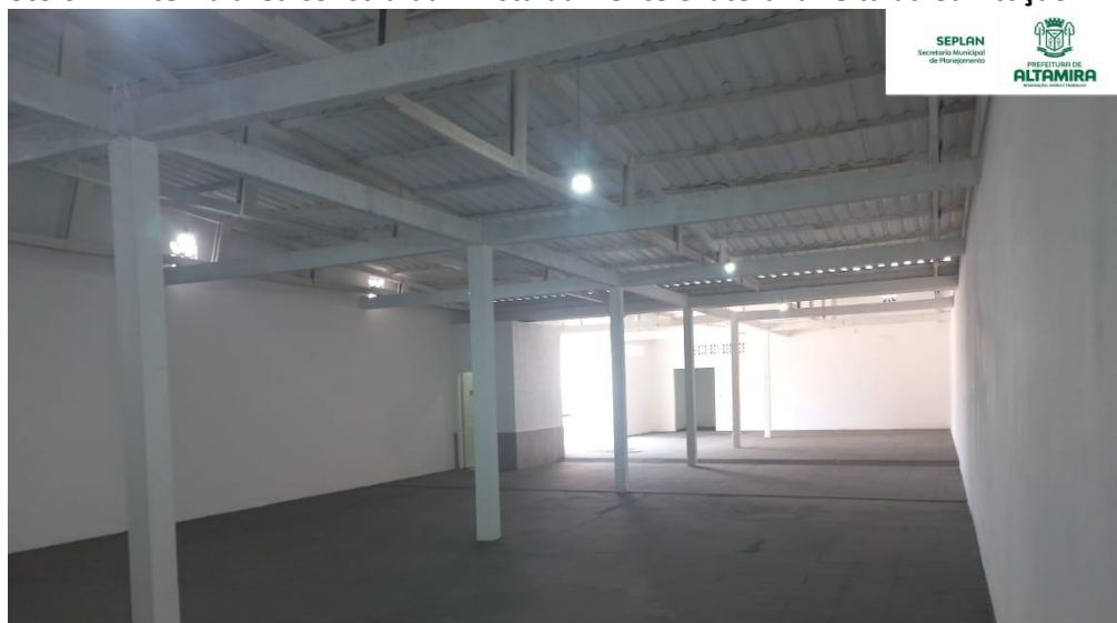
Foto 07 – Interna área construída – vista da frente e lateral direita da edificação
