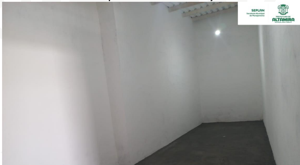
Foto 08 – Depósito aos fundos da edificação
