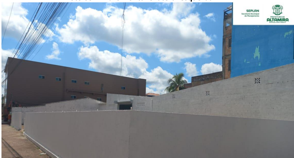
Foto 03 – Muro frontal e lateral esquerda
