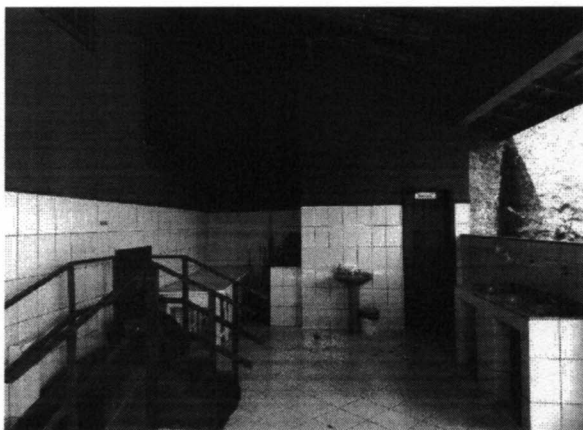
Imagem 19 – Área nos fundos da edificação
