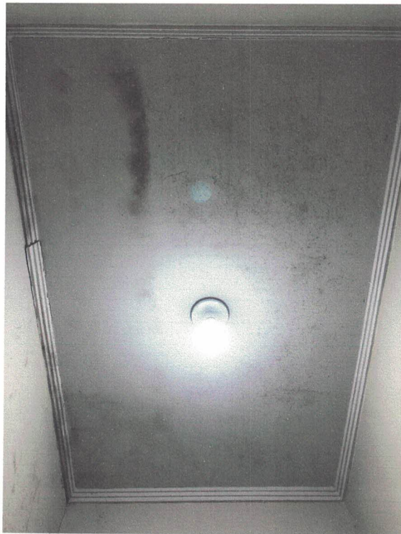
Imagem 26: forro em gesso e iluminação do lavabo.
