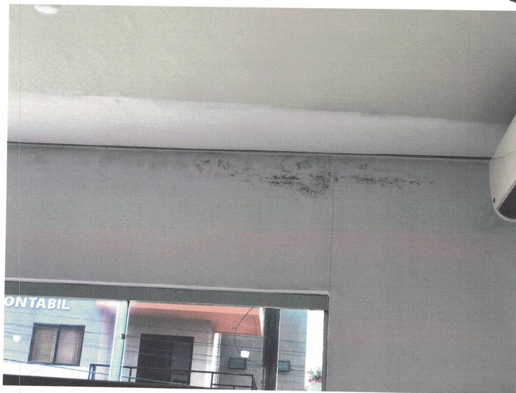
Imagem 16: parede e forro de gesso da recepção.
