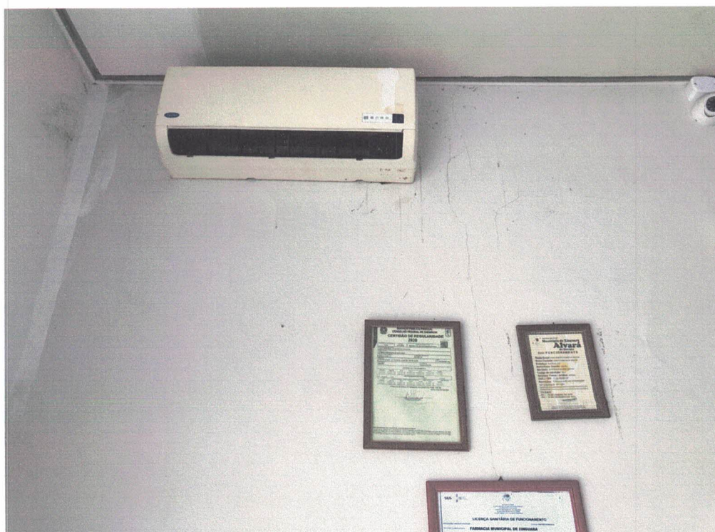
Imagem 07: parede da recepção.
