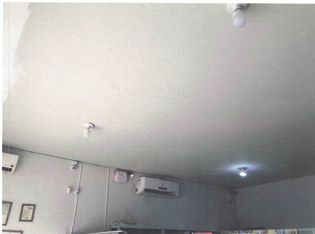
Imagens 29 e 30: forro em gesso e iluminação da edificação.
