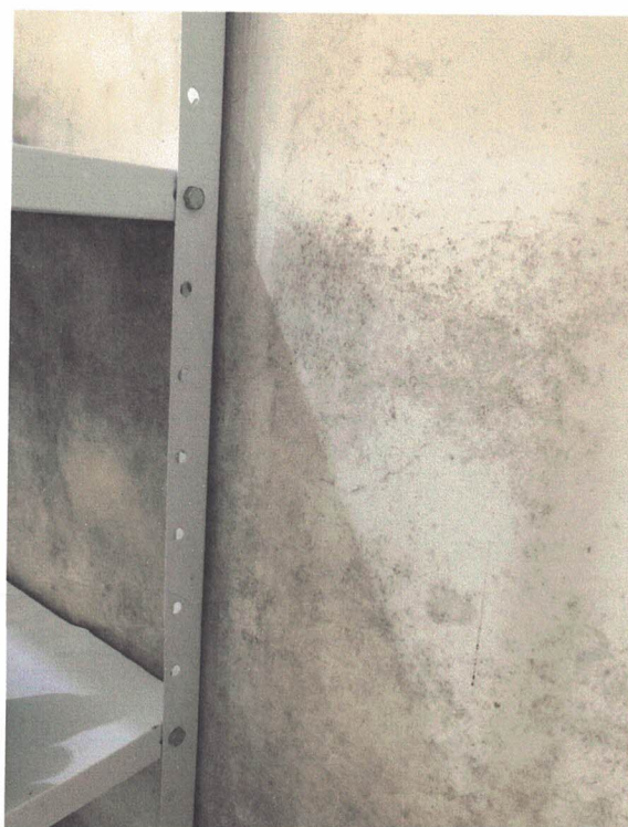
Imagem 13: parede onde as prateleiras de armazenagem estão instaladas.
