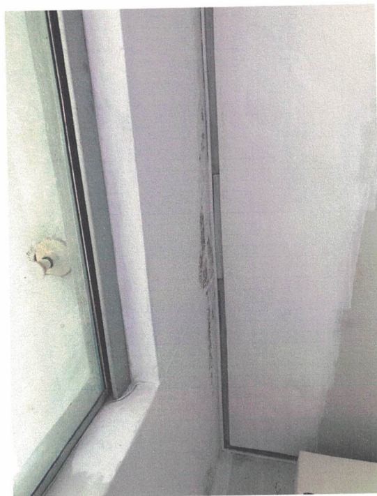
Imagem 08: detalhe do forro da recepção.
