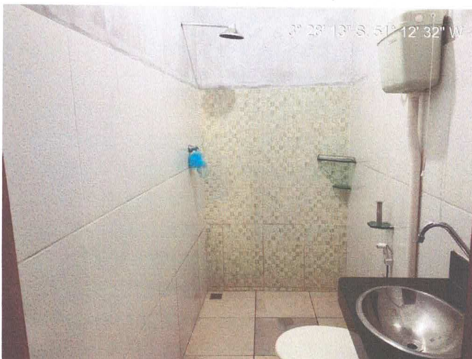
Foto 7 - Ambiente Interno - Banheiro Interno
