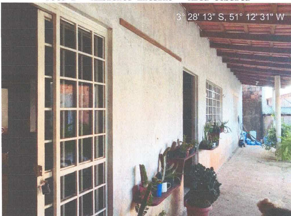
Foto 2 - Ambiente Externo - Área Coberta
