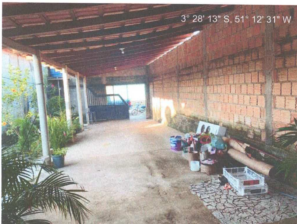
Foto 3 - Ambiente Externo - Área Coberta
