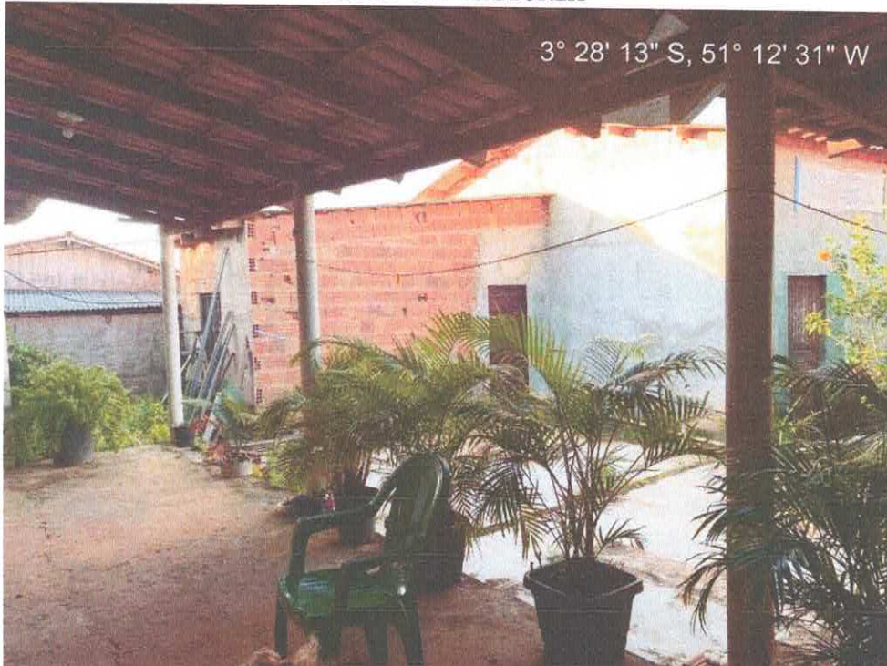
Foto 1 - Ambiente Externo - Área Coberta
