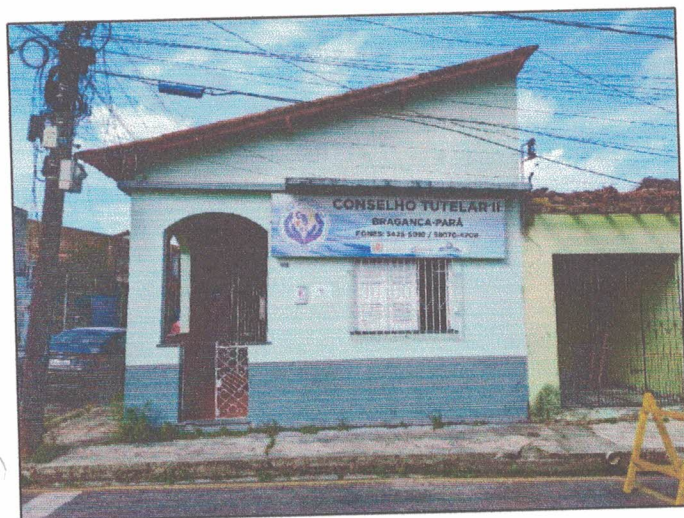
Foto 01: Fachada principal (Rua Marechal Floriano Peixoto). Fonte: Seplan
