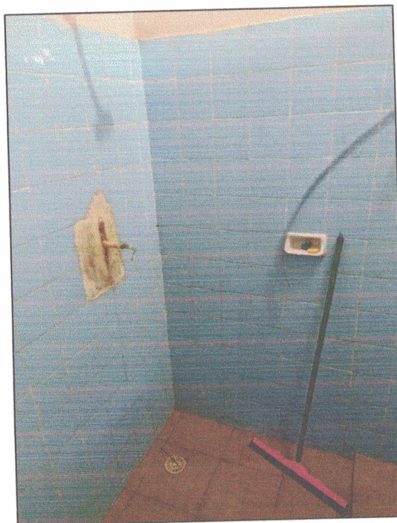
Foto 04: Revestimento cerâmico – Banheiro principal (Baixo padrão). Fonte: Seplan
