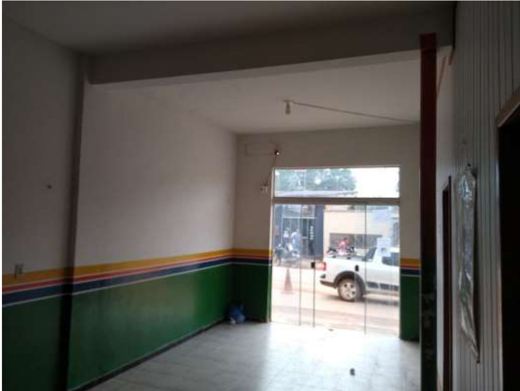
Figura 01 – Vista interna, área frontal.
