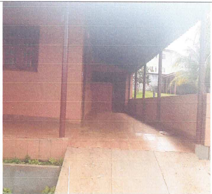
FOTO DA AREA DE ENTRADA
