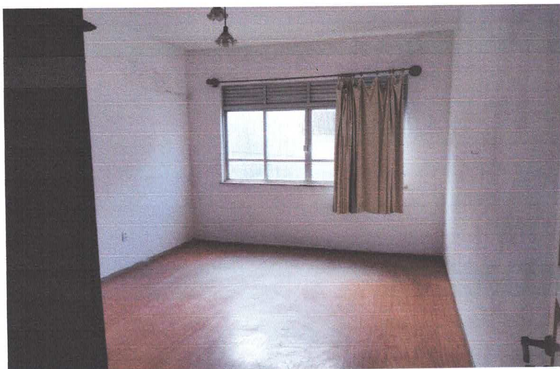
Figura 11; suíte com janela de alumínio e vidro, piso em madeira laminada.
